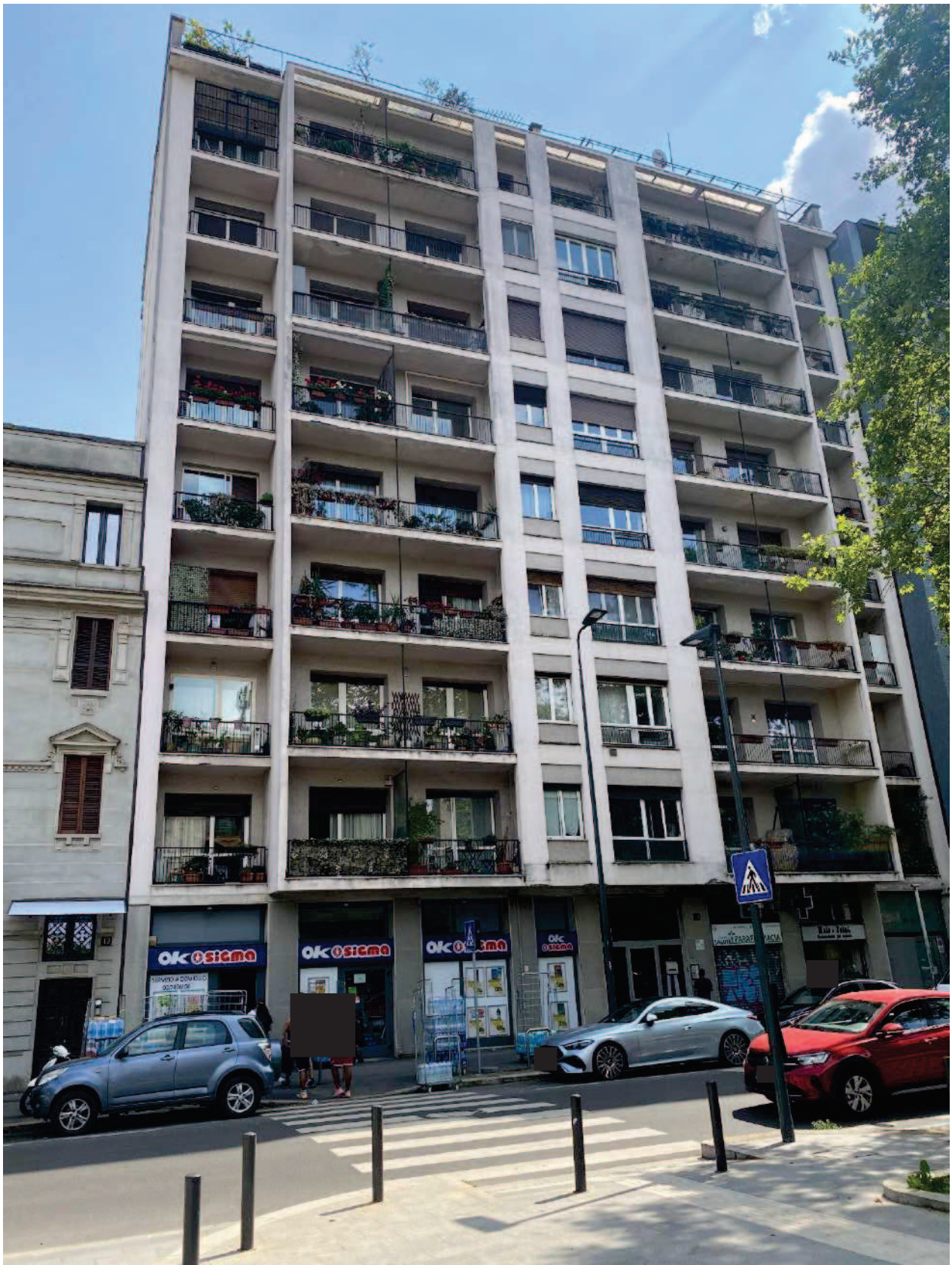
Edificio di Viale Argonne 10
