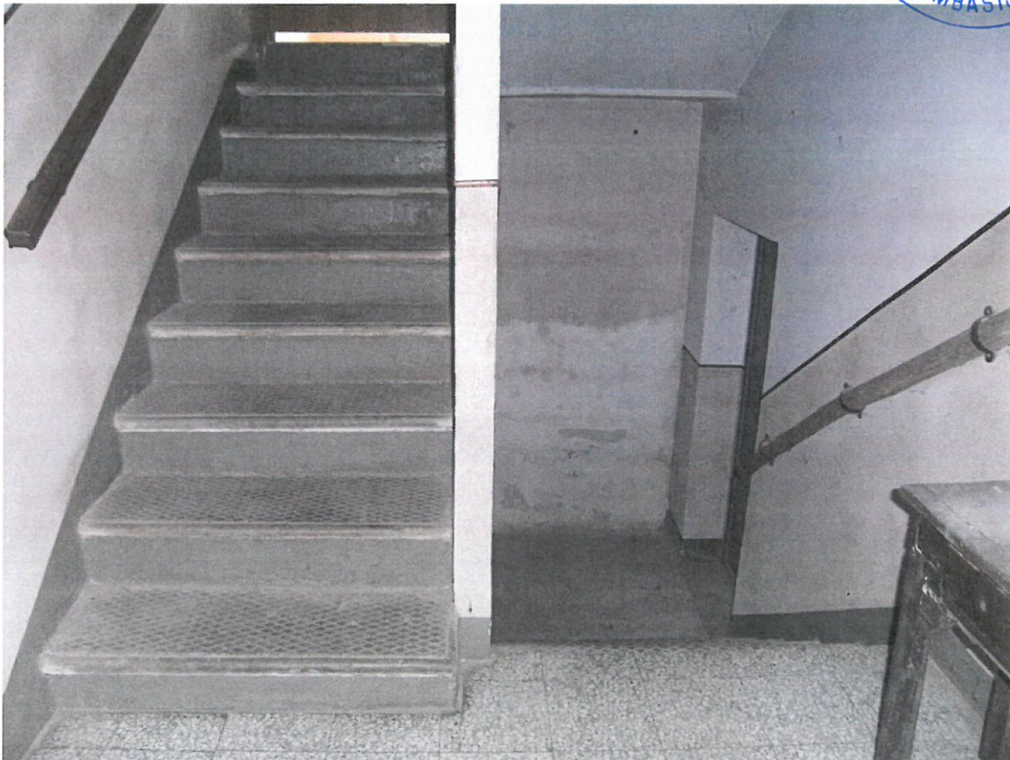
2. LOTTO 2 - VANO SCALA COMUNE ACCESSO CANTINA - F. 10 N. 379 SUB .17.JPG
