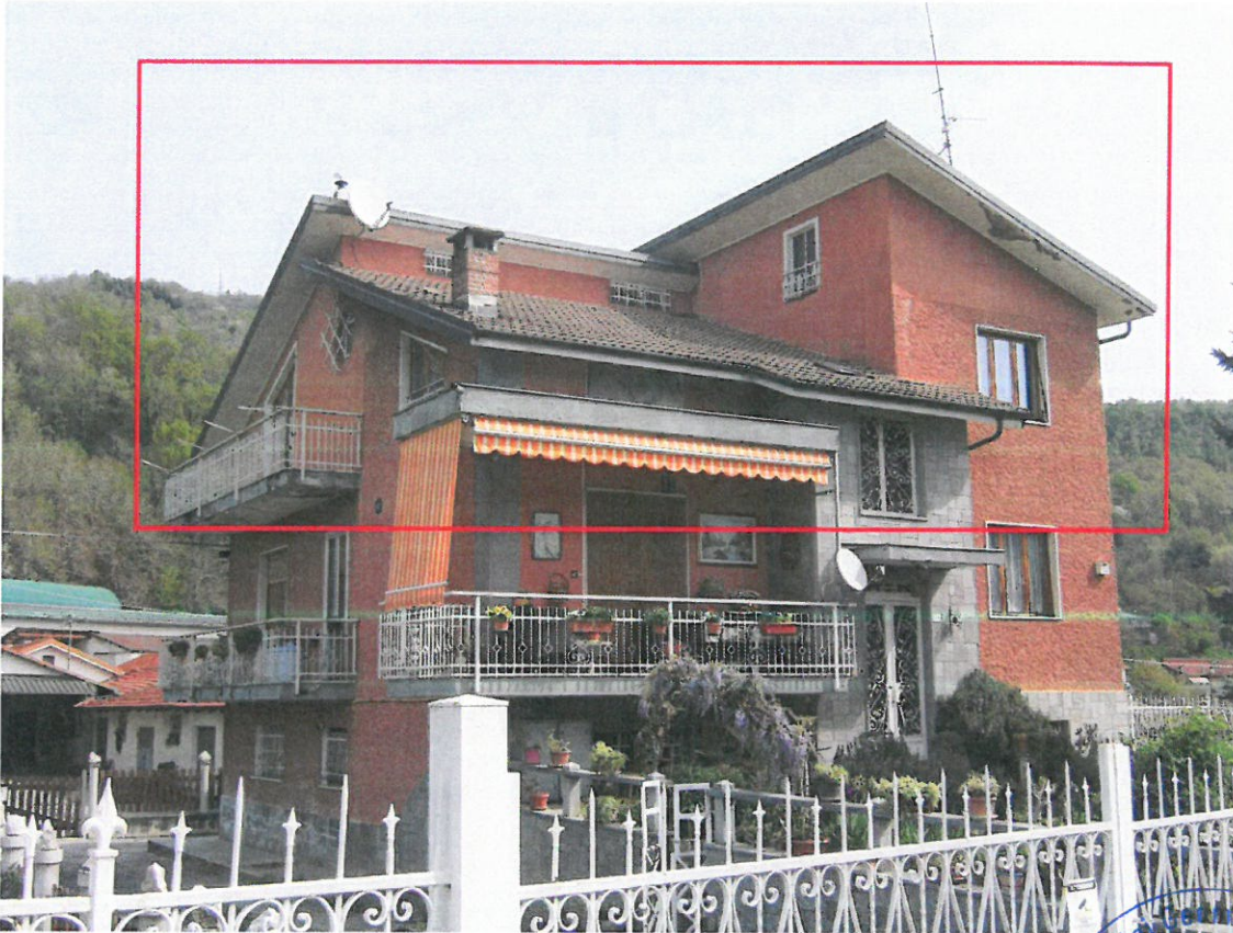
1. LOTTO 1 - PROSPETTIVA DA SUD-OVEST - F. 10 N. 379 SUB. 16.JPG
