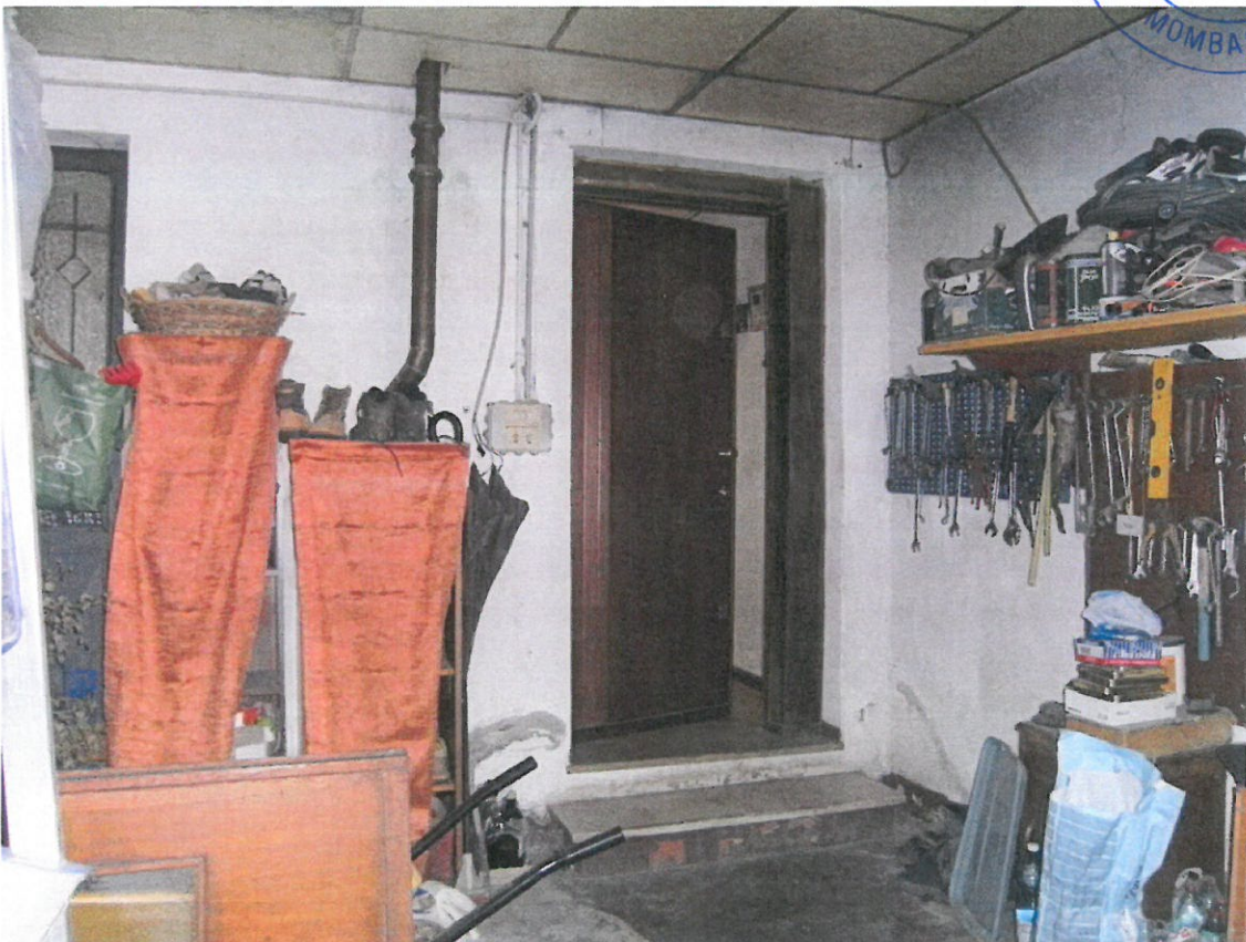
8. LOTTO 3 - DISIMPEGNO - F. 10 N. 379 SUB. 18.JPG
