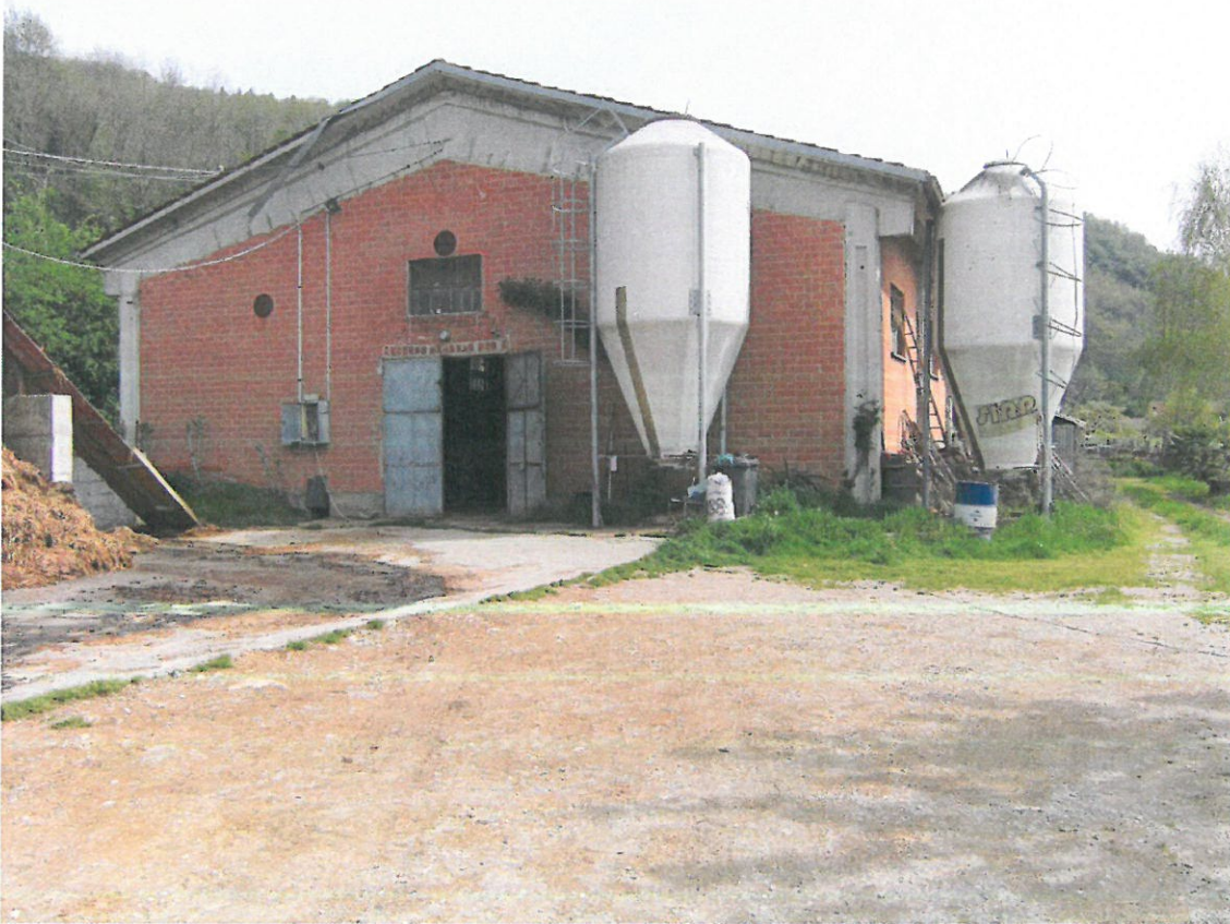
1. LOTTO 4 - PROSPETTO OVEST STALLA - F. 10 N. 758 SUB. 2.JPG
