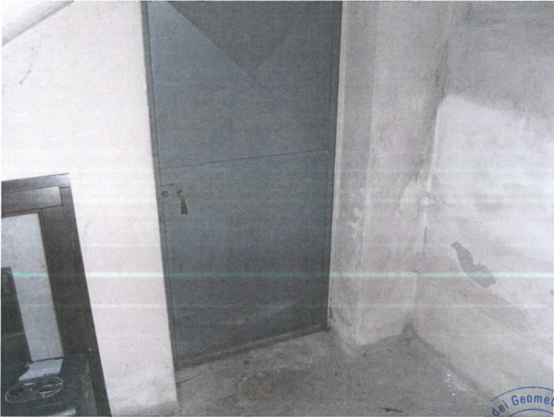
1. LOTTO 2 - INGRESSO CANTINA - F. 10 N. 379 SUB. 17.JPG
