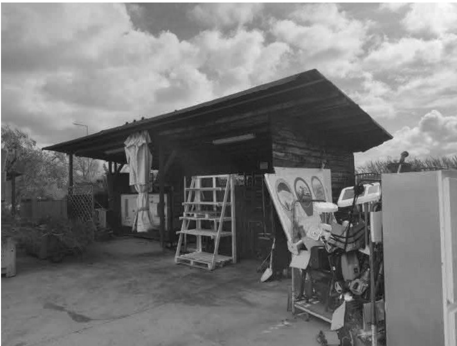
Foto 3 la tettoia in legno corrispondente alla sagoma n. 4 sul rilievo
