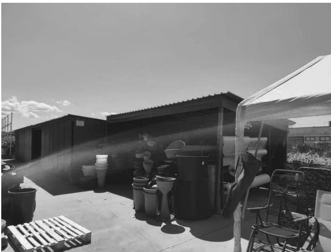
Foto 5 le tettoie da demolire indicate sul rilievo con il n. 1 a sinistra e il n.2 a destra
