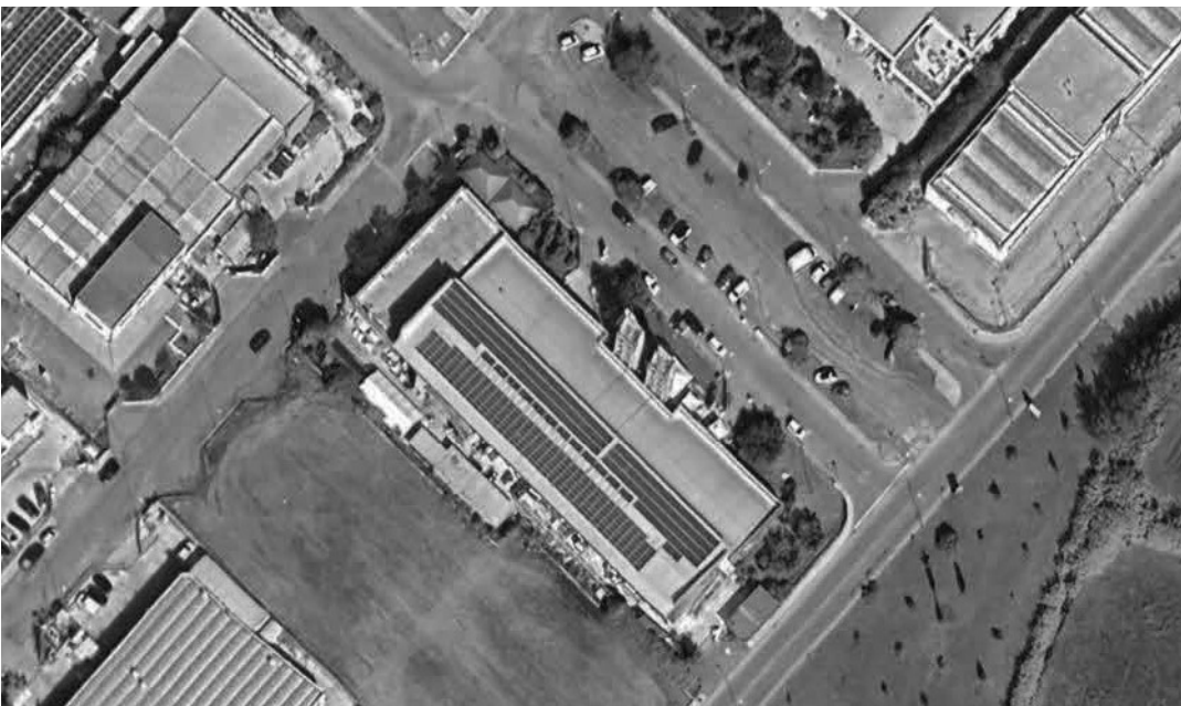
Foto 7 Aerofoto dal quale si evince la superficie occupata dall'impianto fotovoltaic
