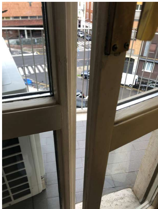
Dettaglio porta finestra lato interno
