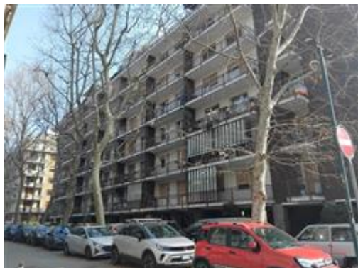
veduta facciata su via Lanfranco dell'edificio
