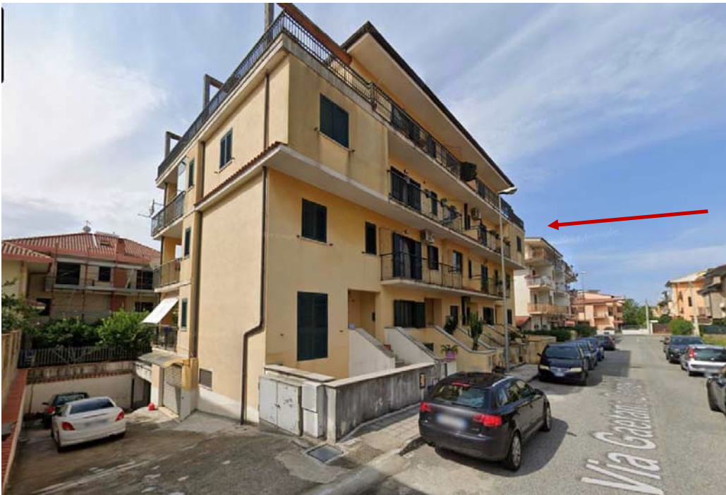
Appendice IV foto satellitare 3D (immagine estratta dal sito “Google maps”) del Comune di Lamezia Terme – con individuazione in rosso del fabbricato in cui insiste il bene immobile n. 1 oggetto della procedura esecutiva - prospettiva lato Nord-Est.
