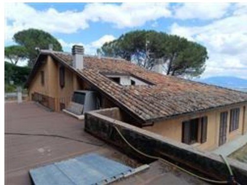
RETRO PROSPETTO E TETTO
