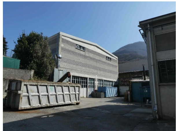
capannone corpo B e piazzale
