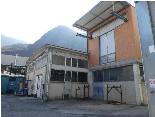
capannone corpo A verso piazzale su retro
