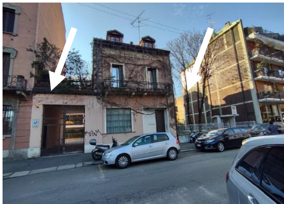
Fronte strada: accesso carraio e pedonale
