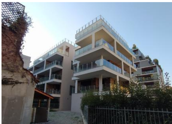
Vista del fabbricato dall'ingresso pedonale
