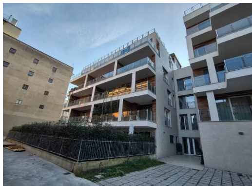
Ingresso al fabbricato
