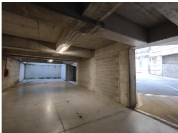
Interno del parcheggio interrato
