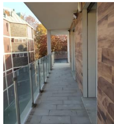
Balcone del complesso
