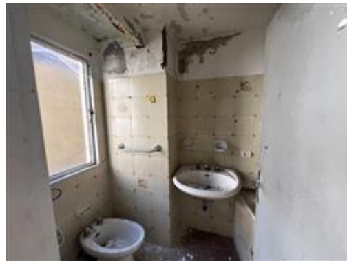
vista interna bagno al Piano Primo
