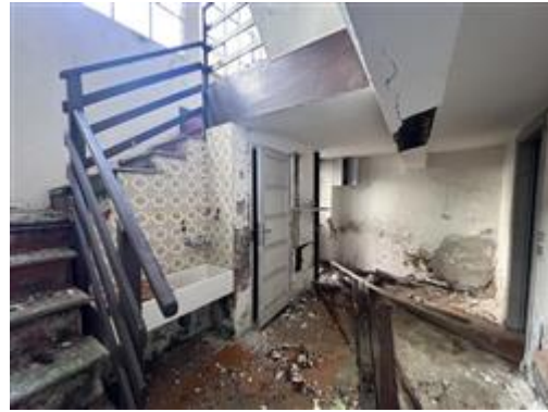
vista interna scala interna al Piano Terra
