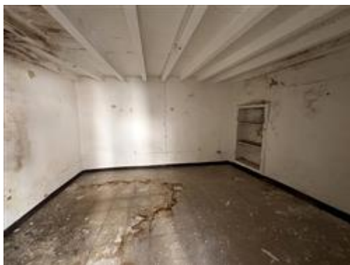
vista interna locale al Piano Primo
