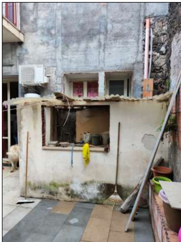
Figura 13 - Vista del locale ripostiglio realizzato nell'area esterna di pertinenza esclusiva.
