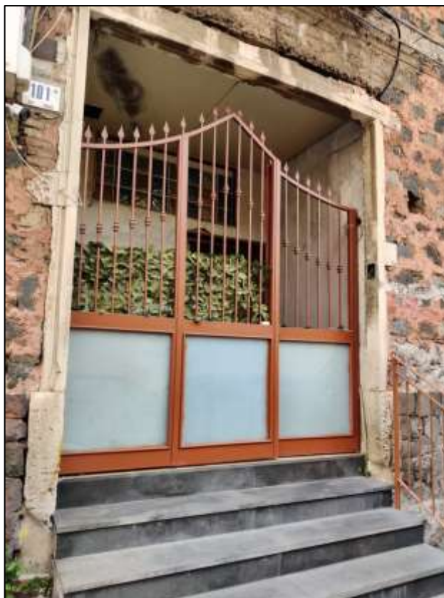
Figura 3 - Vista del cancello di accesso dalla Via Faraci n°101.
