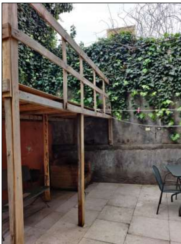
Figura 14 - Vista della struttura precaria in legno realizzata nell'area esterna.
