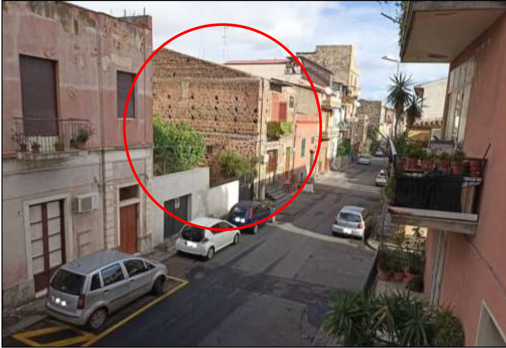
Figura 1 - Vista del fabbricato dalla Via Faraci.
