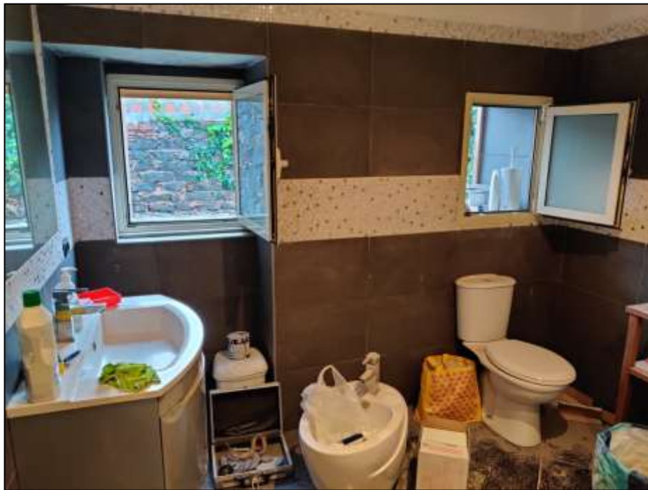
Figura 27 - Vista del locale wc al piano primo.
