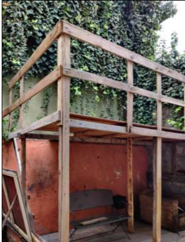
Figura 15 - Altra vista della struttura precaria in legno realizzata nell'area esterna.
