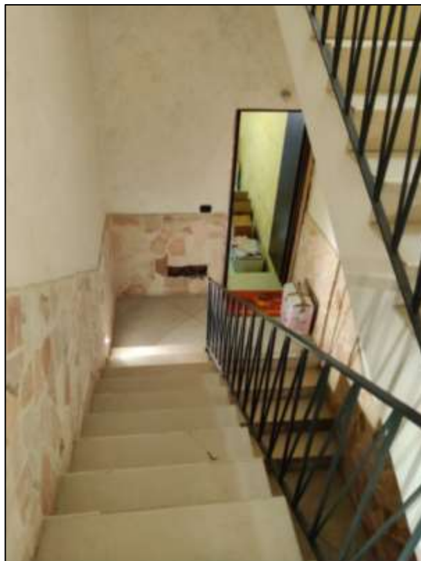
Figura 16 - Vista della scala interna di collegamento tra piano terra e piano primo.
