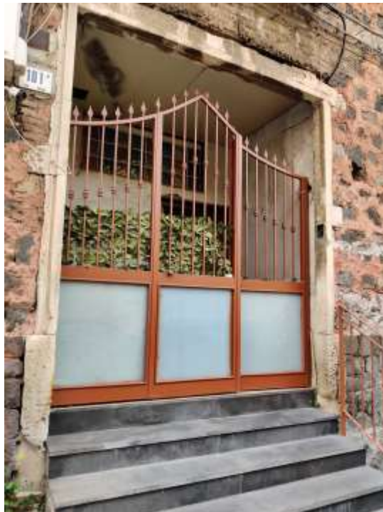
Figura 3 -Vista dell'accesso dal civico n.101 di Via Faraci.
