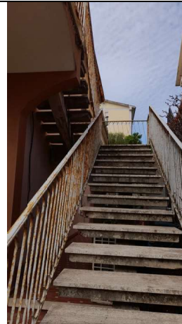
Scala esterna accesso piano primo
