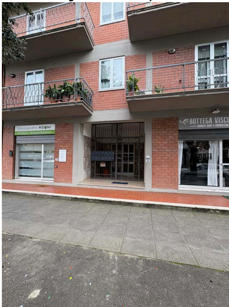
FOTO 2 (vista esterna su ingresso a comune)
