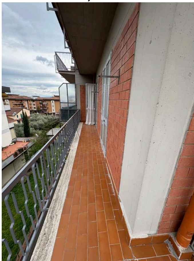
FOTO 12 (vista esterna su terrazzo)
