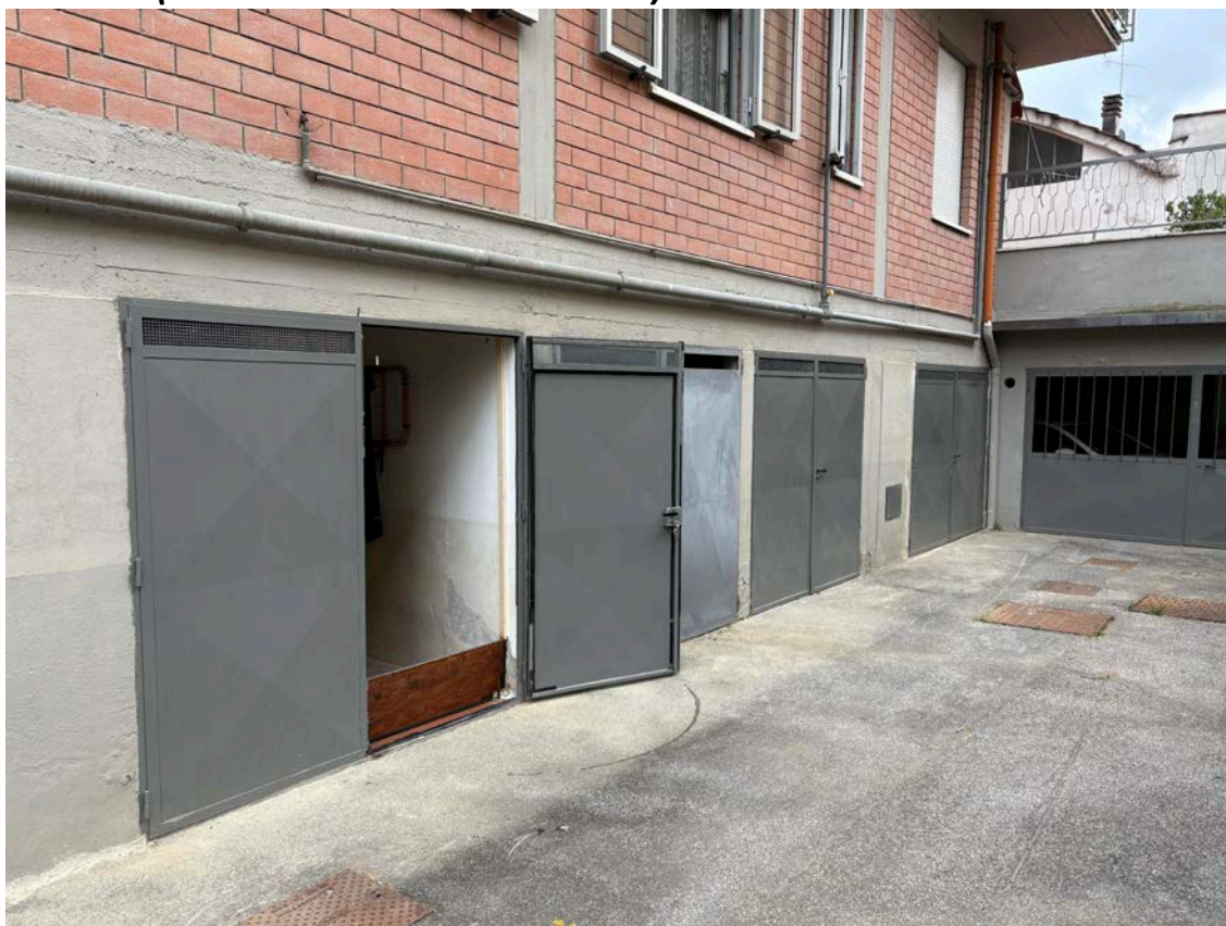
FOTO 13 (vista esterna su autorimessa)
