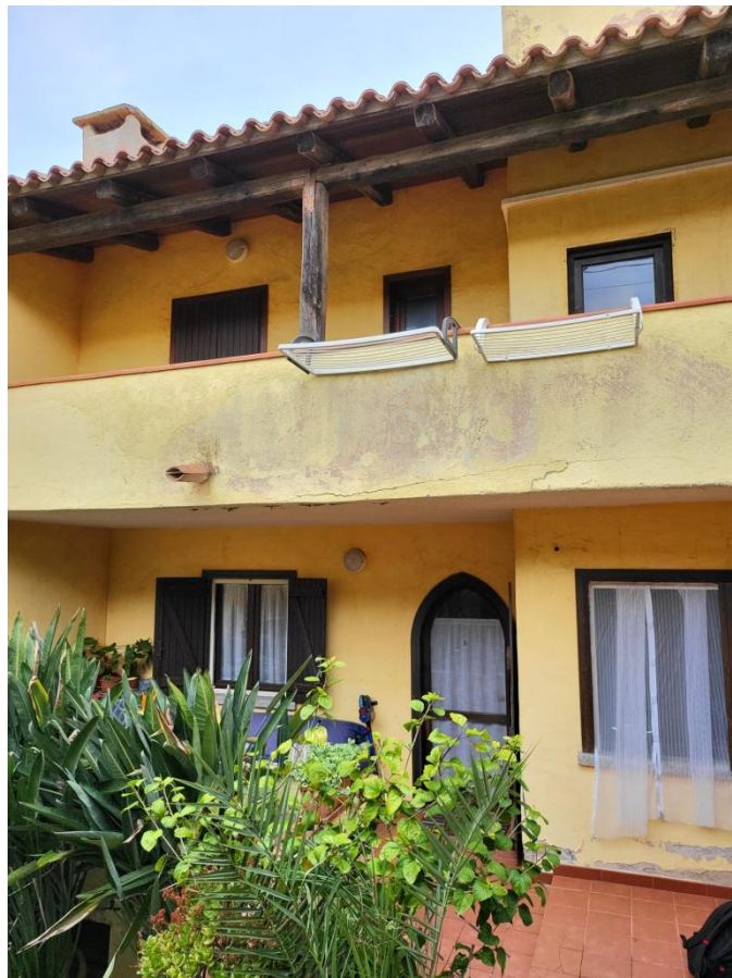
Foto 16 – Zona di accesso all'appartamento piano terra identificato al sub 1 da via Vespucci
