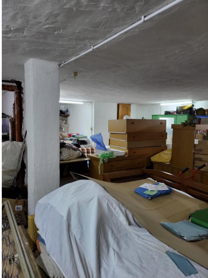
Foto 6 – Interno magazzino seminterrato identificato al sub 7
