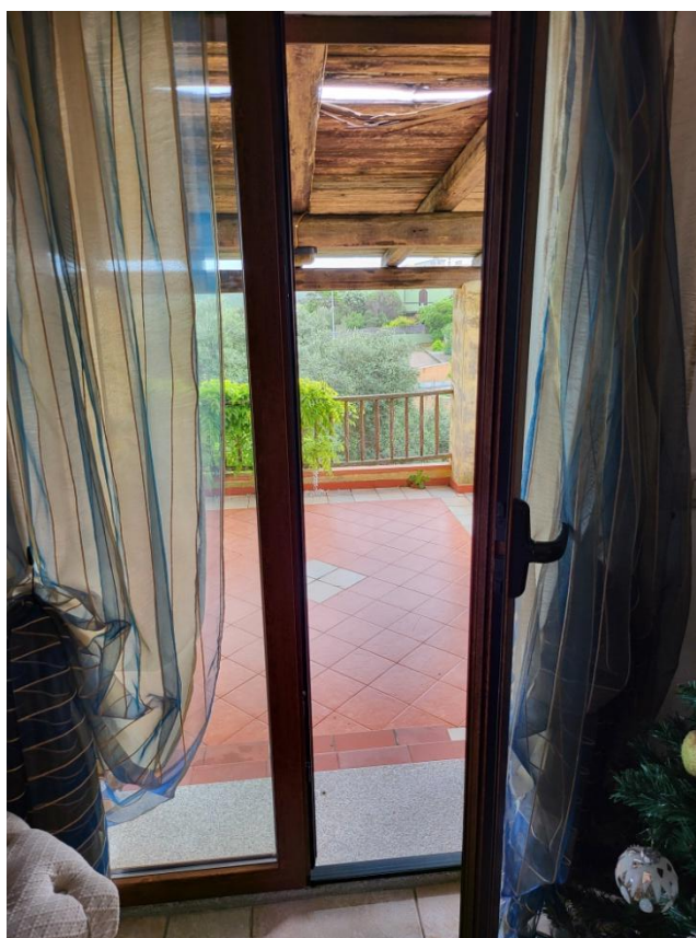
Foto 19 – veranda realizzata senza concessione a cui si accede dall'appartamento posto al piano primo identificato al sub 6
