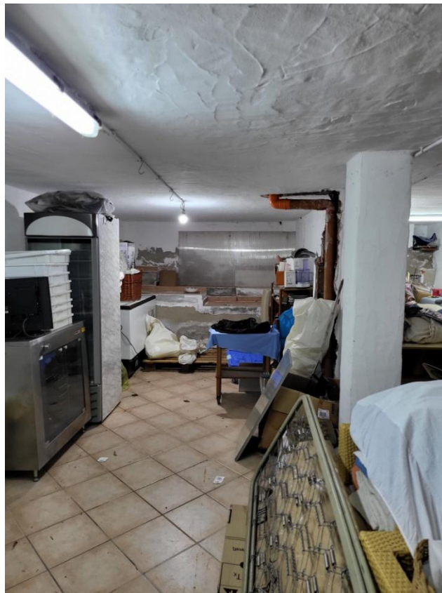
Foto 5 – Interno magazzino seminterrato identificato al sub 7
