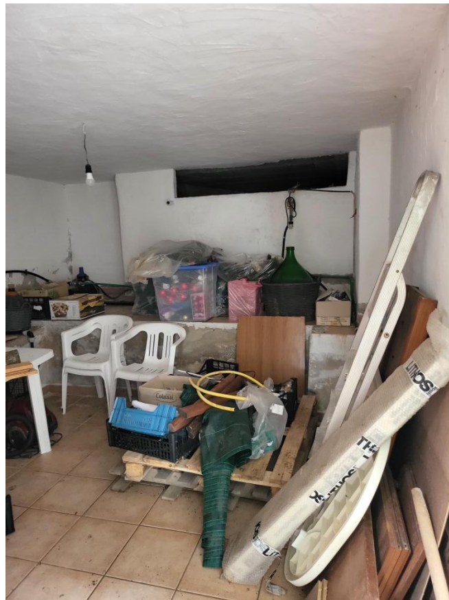
Foto 3 – Magazzino seminterrato identificato al sub 4
