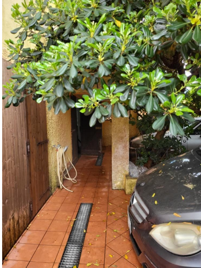
Foto 4 – Ingressi al magazzino seminterrato identificato al sub 7
