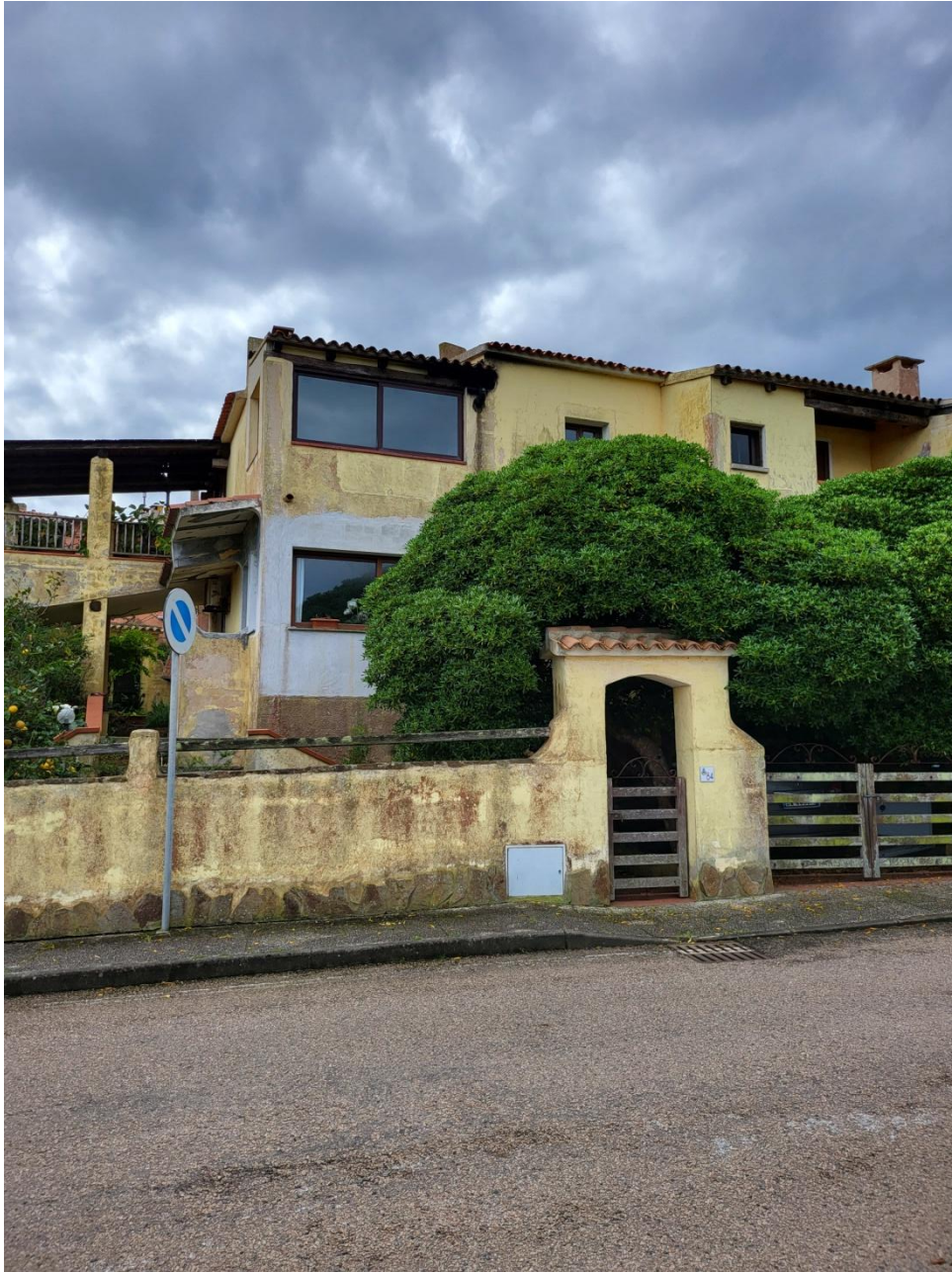
Foto 1 - Prospetto su via Cormorani
