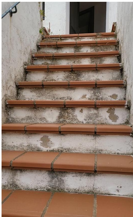
Foto 12 – Scala di accesso al piano primo (sottotetto)
