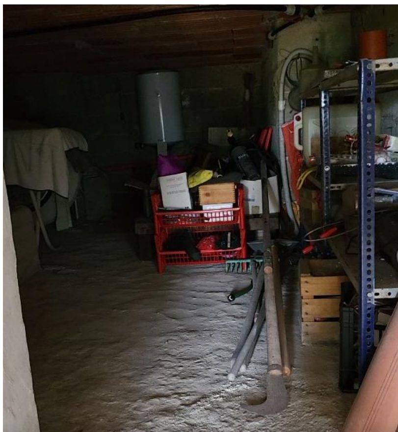
Foto 20 – locale interrato sotto solaio del piano terra H=1,40 m
