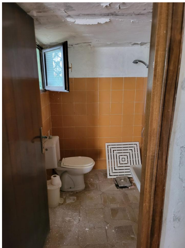
Foto 18 – WC locale cantina
