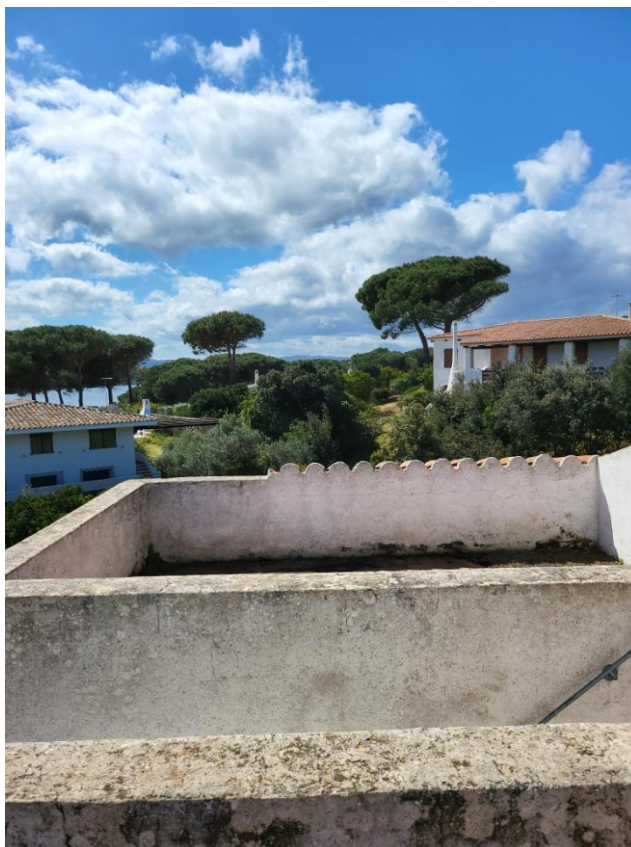
Foto 15 - Terrazze al piano primo
