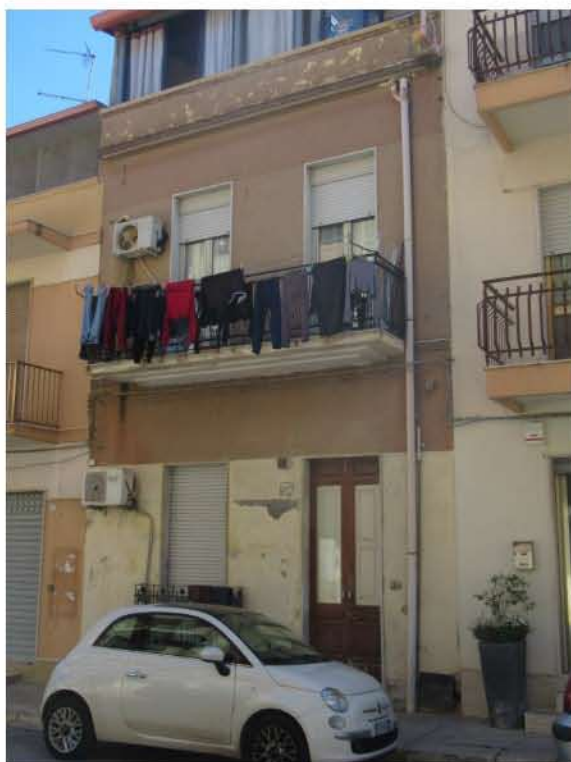
Foto 3_ Prospetto su Via M. Rapisardi
