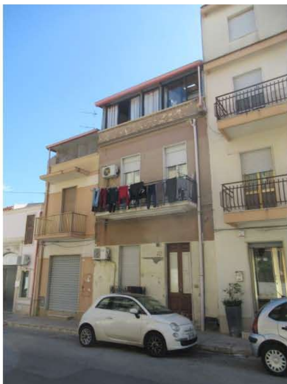
Foto 1_ Prospetto su Via M. Rapisardi
