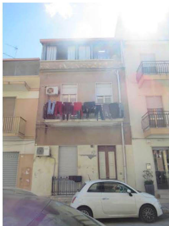
Foto 2_ Prospetto su Via M. Rapisardi
