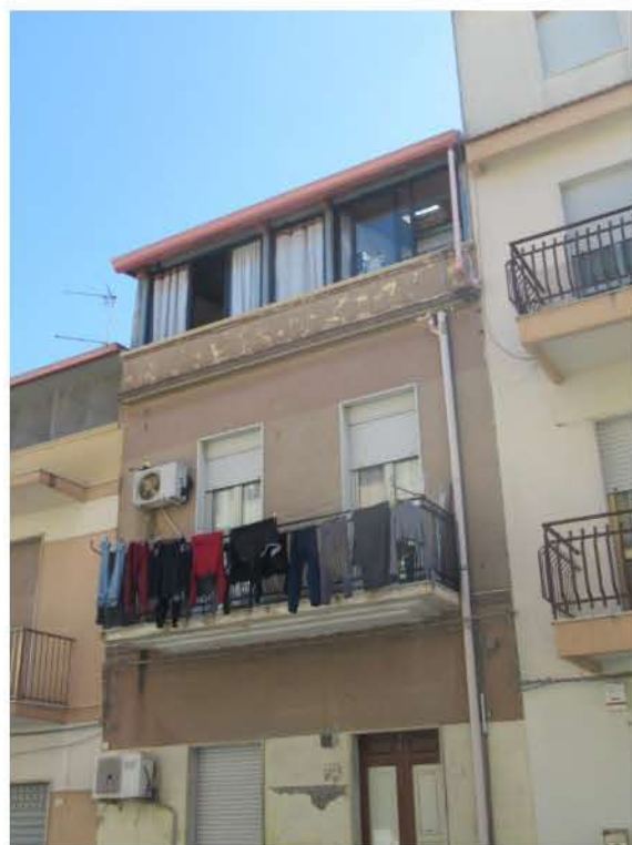
Foto 4_ Prospetto su Via M. Rapisardi
