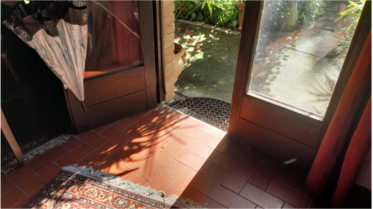
FOTO 16 – PARTICOLARE ACCESSO VERANDA DA SUD
