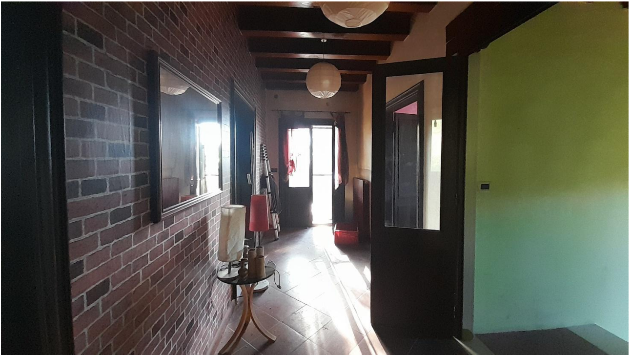
FOTO 32 – CORRIDOIO AL PIANO PRIMO
