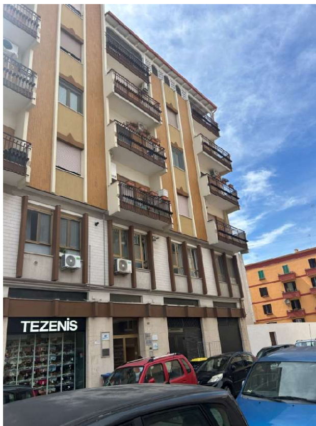
Foto 1: Vista esterna dell'edificio
