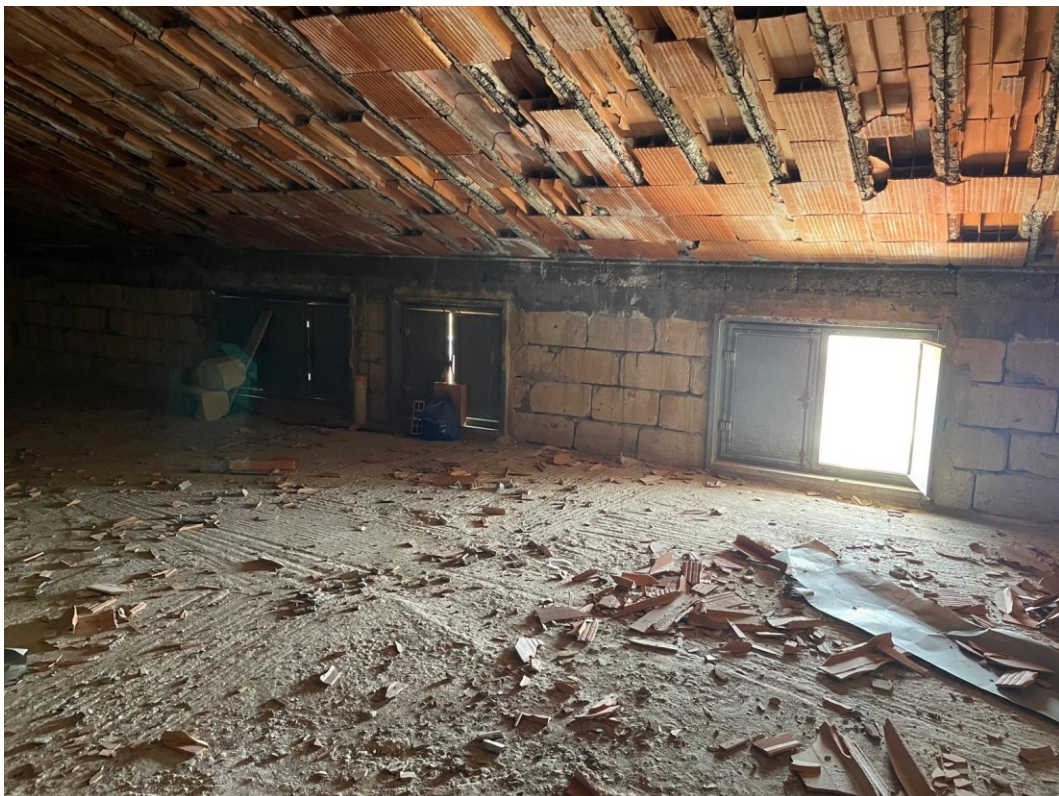
Interno del deposito
