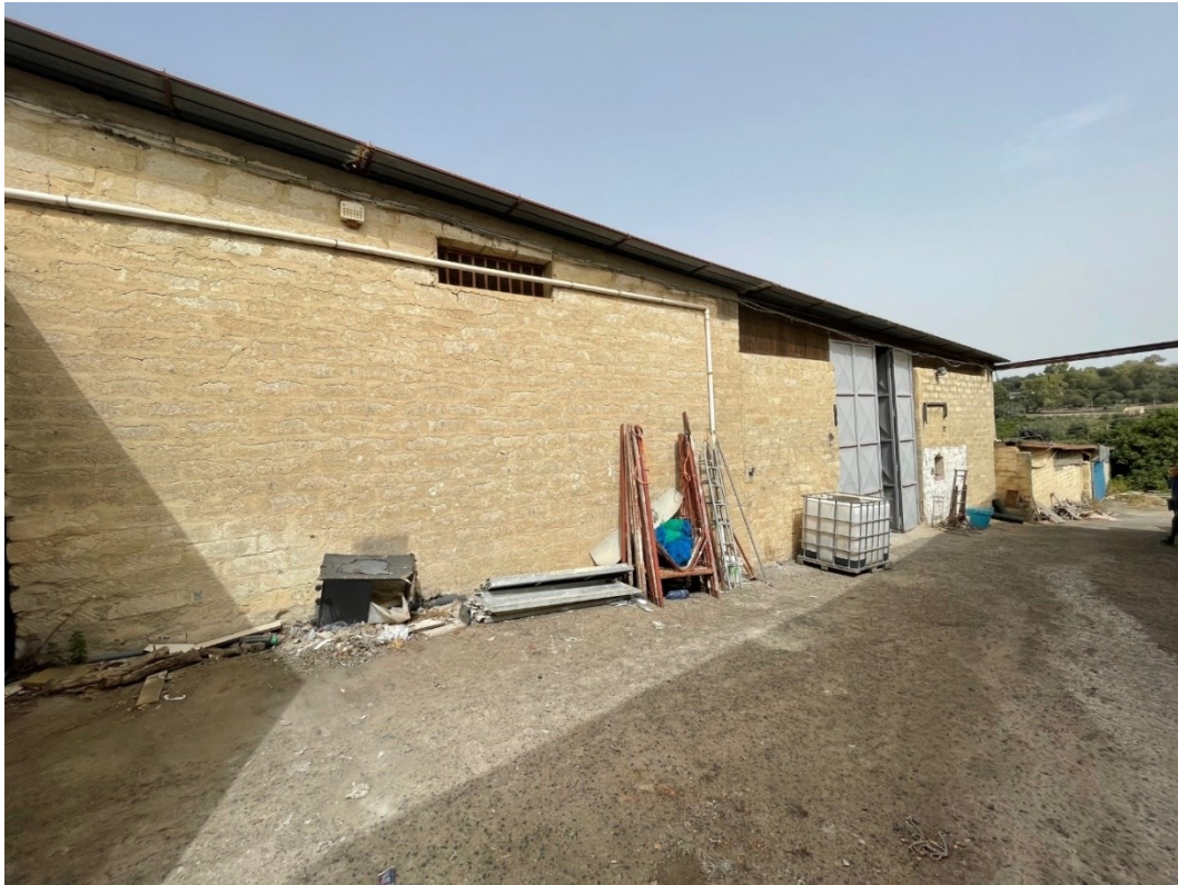
Magazzini e area di pertinenza all'interno della particella n. 322
