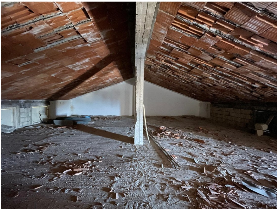
Interno del deposito
