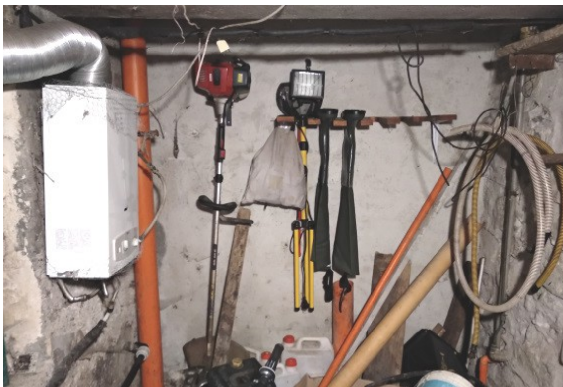
FOTO 19 – interno portico piano terra
