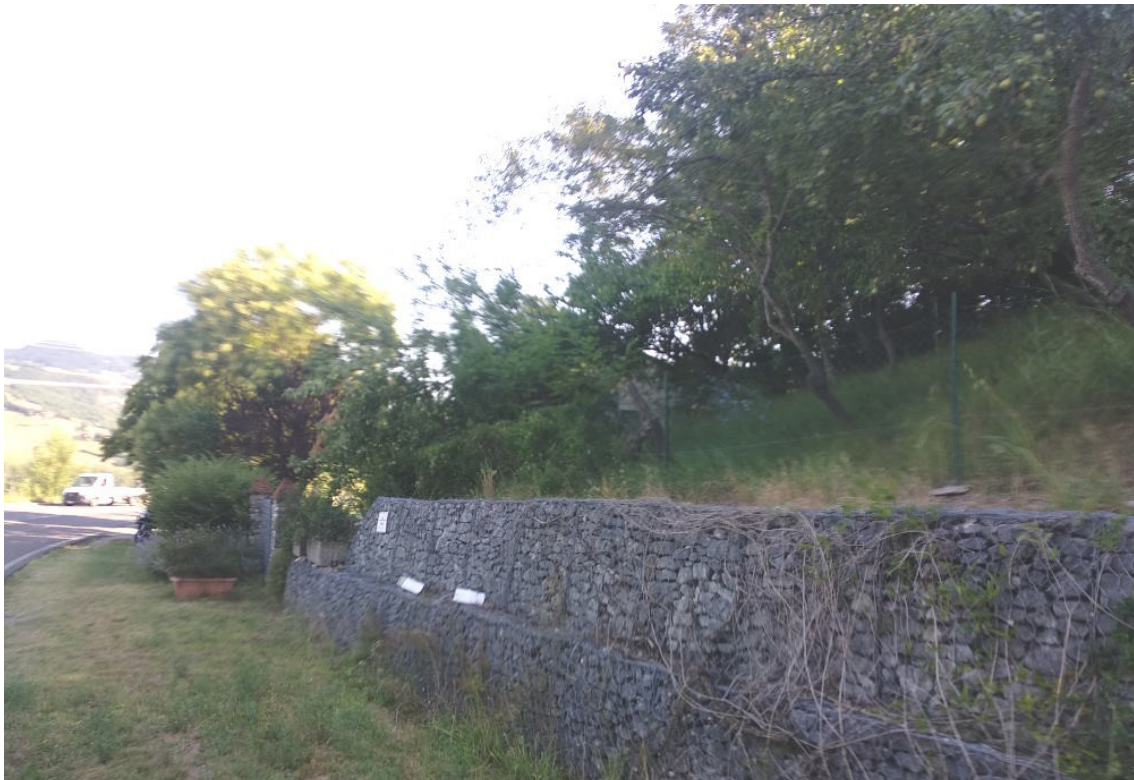
FOTO 21 – corte fronte strada
