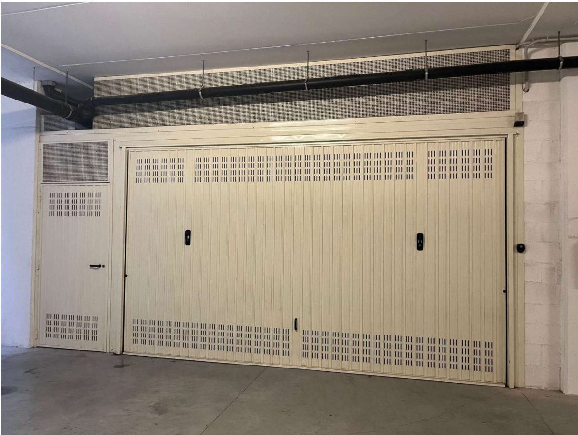
Veduta ingresso garage sub 72
