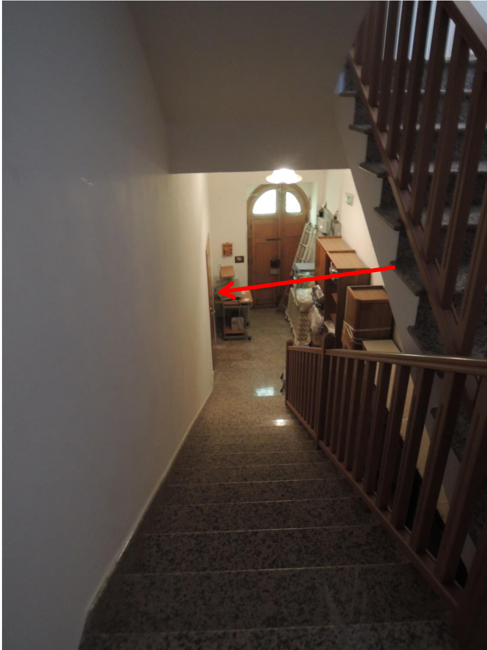
Figura 5 Accesso interno vano scala sub. 3
