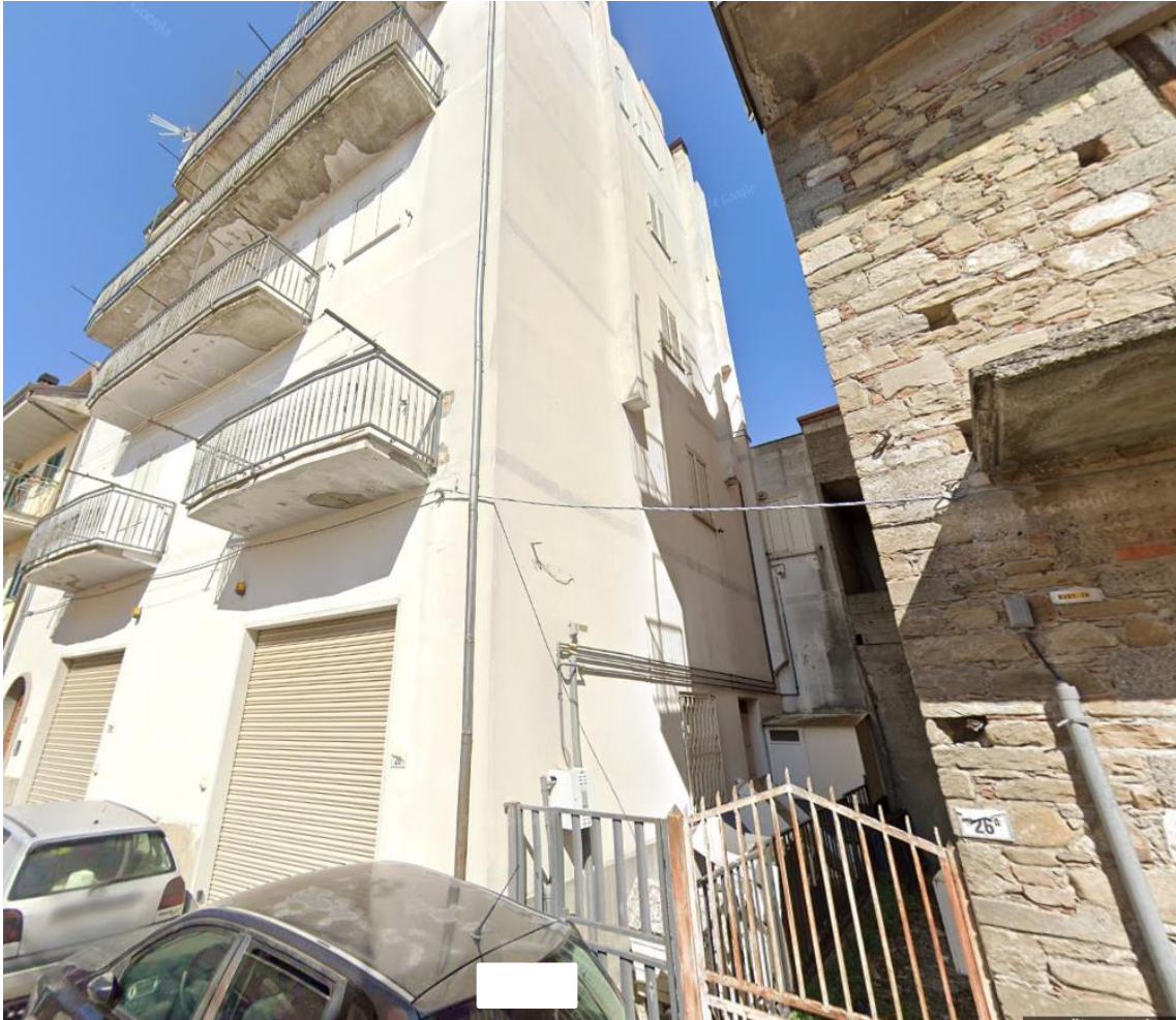
Figura 4 Accesso pedonale sub. 2 Via dei Lucani
