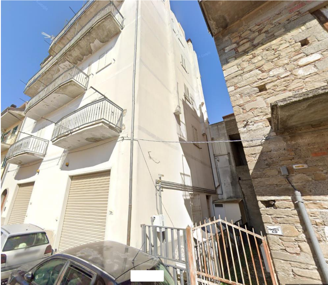
Figura 4 Accesso pedonale sub. 2
