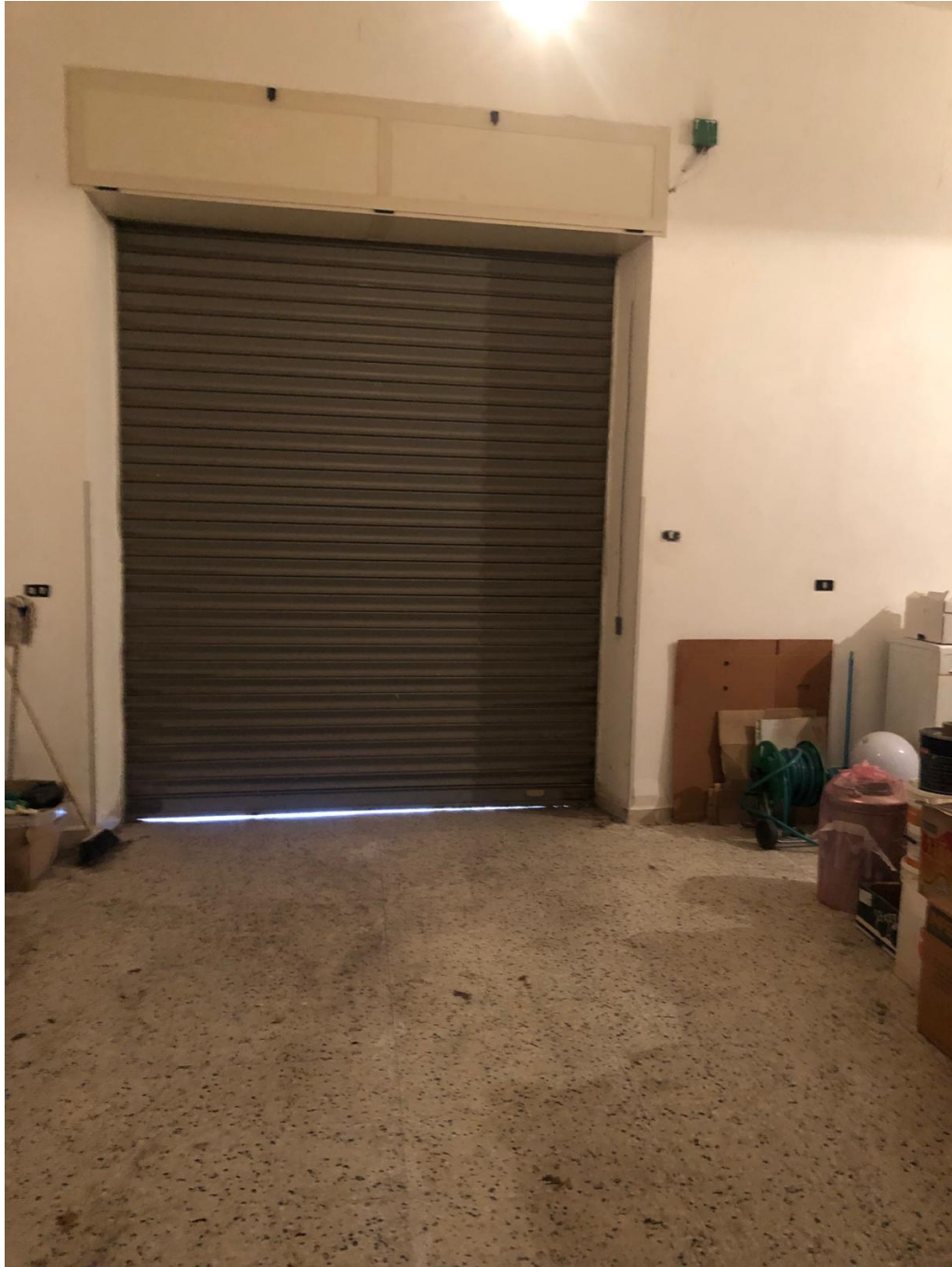
Figura 8 Interno locale paino terra sub. 2
