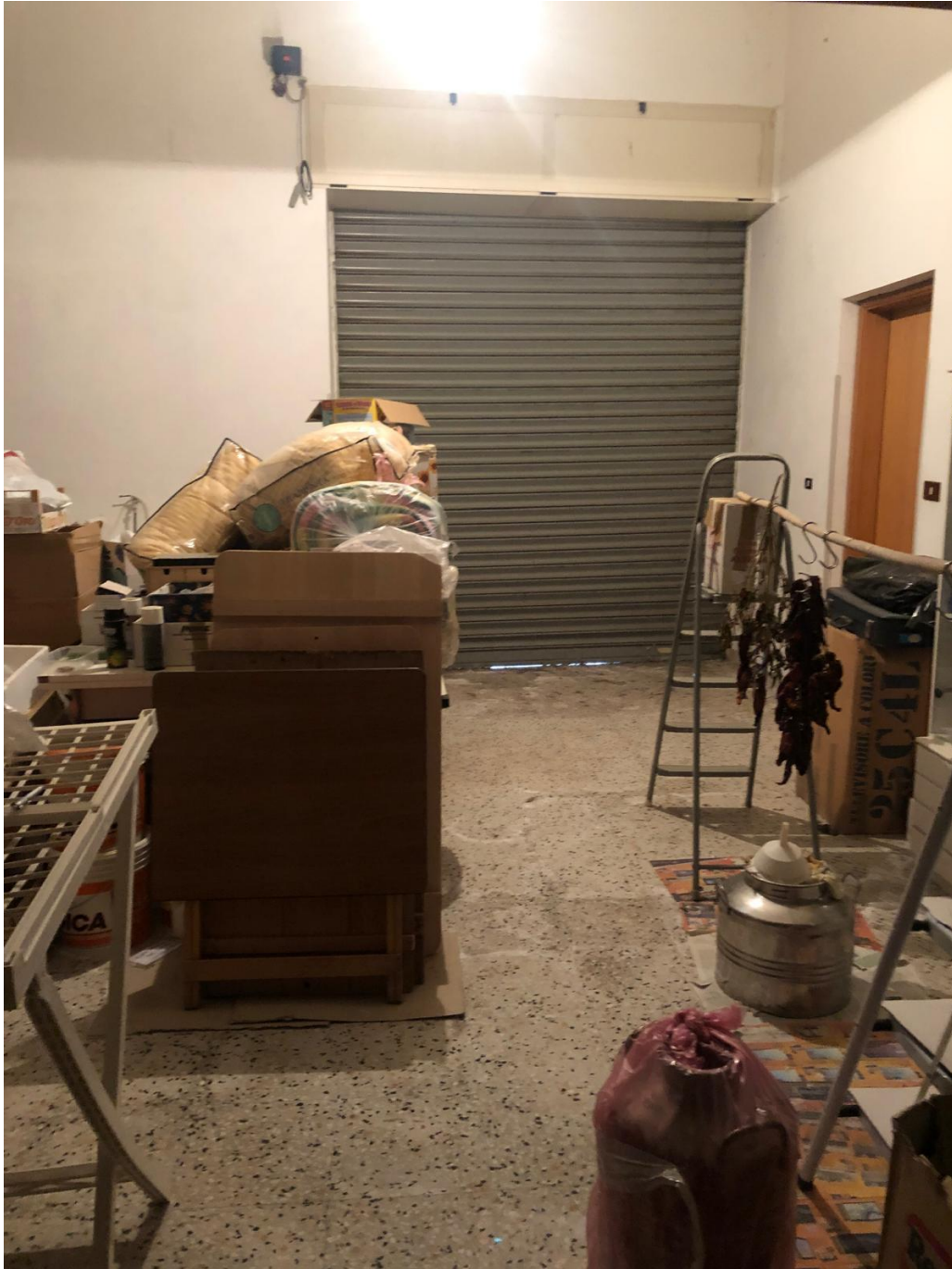
Figura 6 Interno locali piano terra- sub.3
