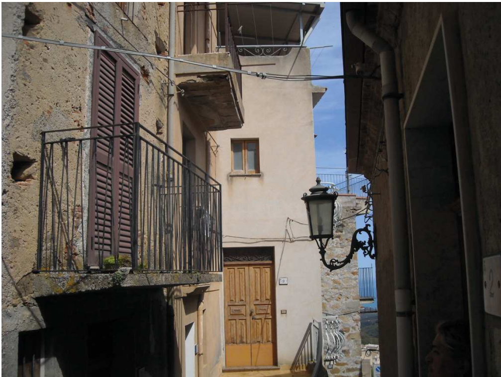
FOTO N. 4 – PROSPETTO OVEST - P.T. – P.1° – P.2° SU VIA SALITA CASTELLO N° 9
