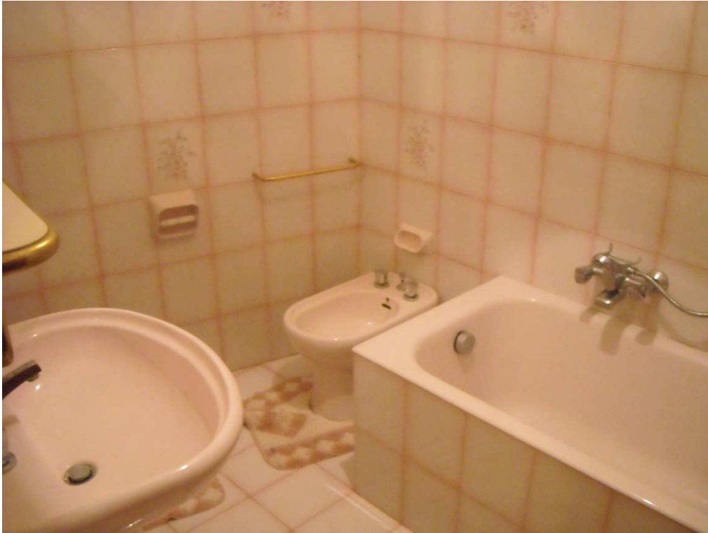
FOTO N. 11 – WC A PIANO TERRA
