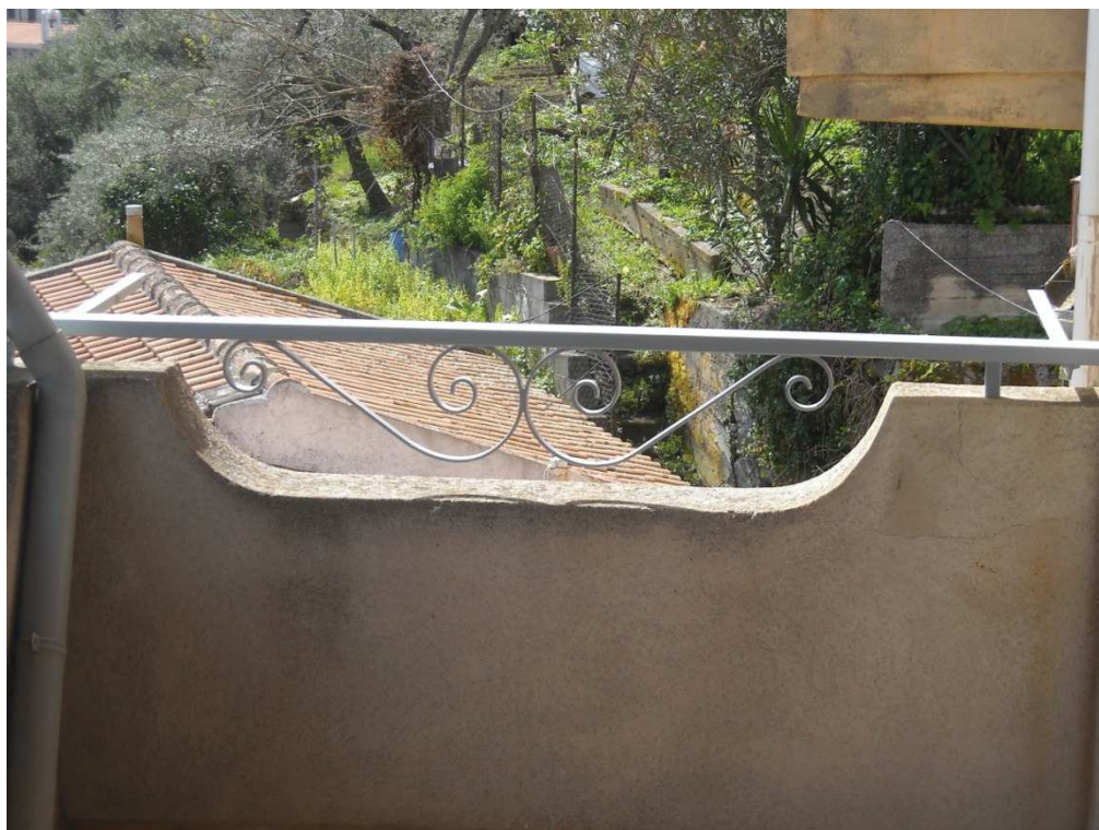
FOTO N. 15 – BALCONE AFFACCIO A PIANO SECONDO
