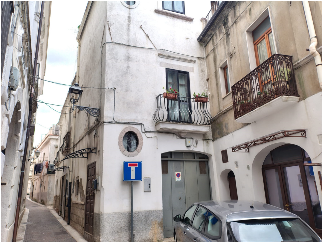
Facciata dell'appartamento oggetto di causa
