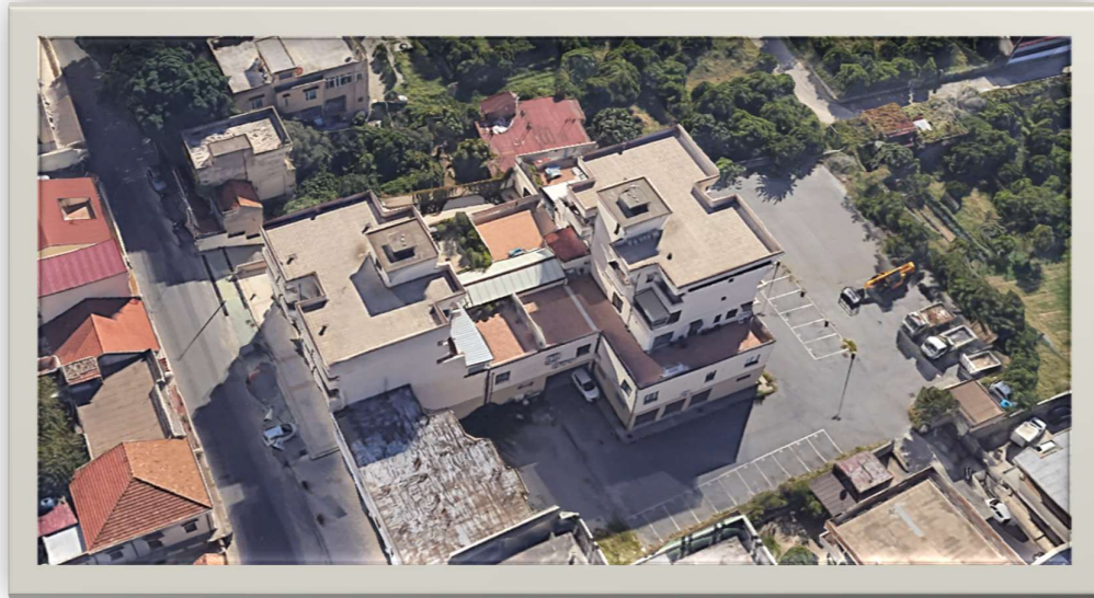
Foto n. 4: Aerofoto del complesso edilizio "Le due Torri" – Catona (RC).
