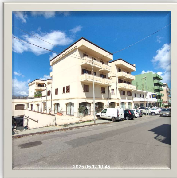
Foto n. 5: vista prospettica del complesso edilizio "Le due Torri" – Catona (RC).
