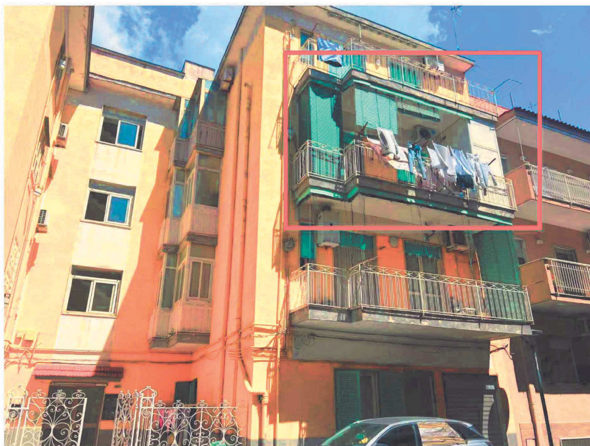
Foto 2 – Dettaglio esterno dell'unità stagitta, sita al piano secondo del fabbricato
