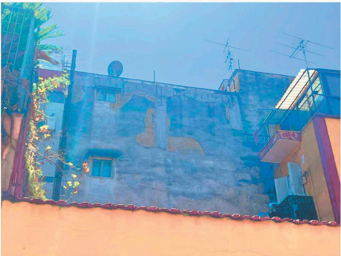
Foto 16 – Vista del retro del fabbricato
