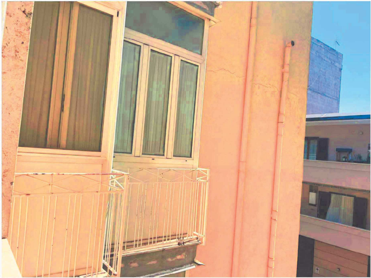
Foto 7 – Vista esterna della veranda di ingresso
