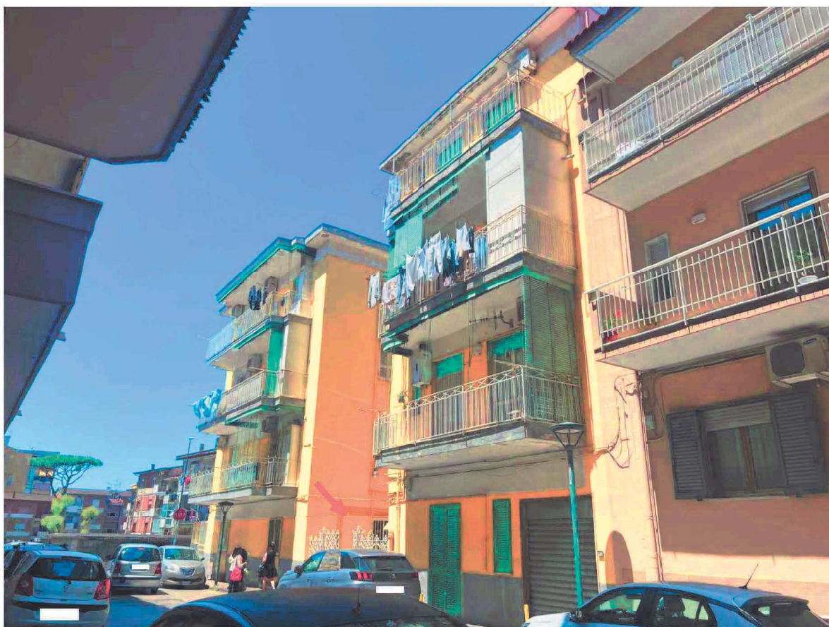
Foto 1 - Vista del fabbricato sito alla I trav. Villa Bisignano n. 257 (già II trav. Cupa Rubinacci n. 257), Napoli
