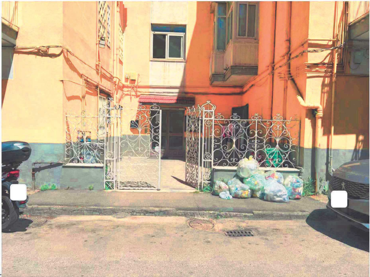
Foto 3 – Vista dell'accesso al fabbricato
