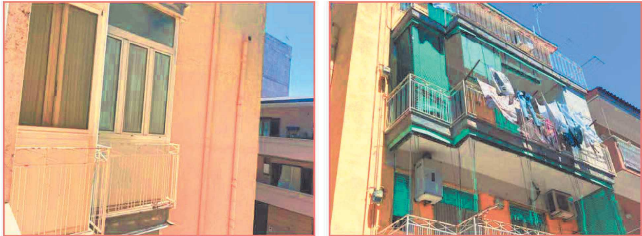
Dettagli di veranda di ingresso e balcone sul fronte strada
