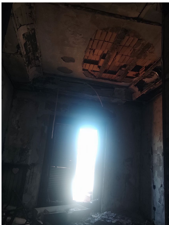
Foto 1 Letto 1 solaio danneggiato Foto 2 Letto 1 solaio danneggiato
