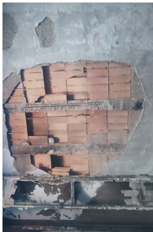
Foto 1 Letto 1 solaio danneggiato Foto 2 Letto 1 solaio danneggiato
