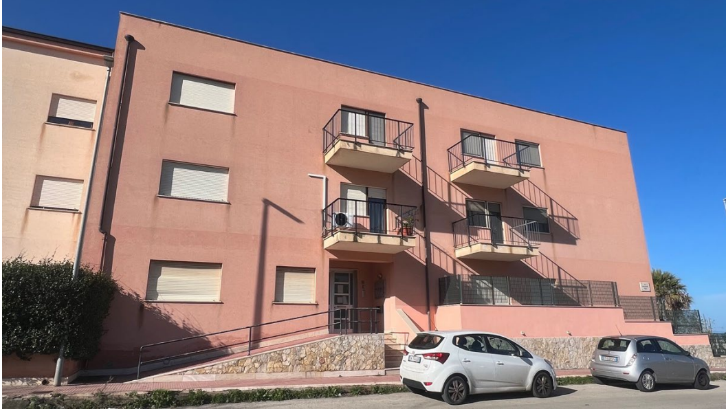
FOTO 1 - PORZIONE PROSPETTO VIA DON G. GIARDINA
