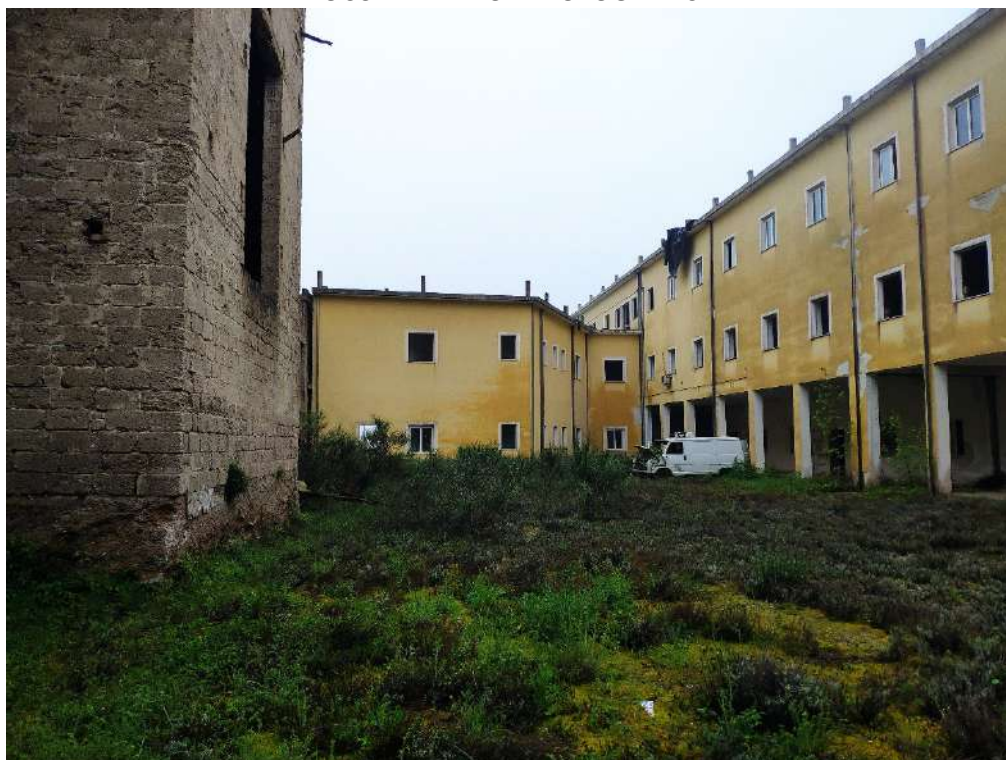
foto n° 22 - Vista esterna Immobile Bene 6 corte
