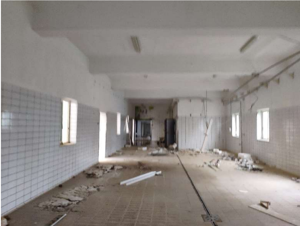
foto n° 5 - Vista interna Immobile Bene 1 Piano terra
