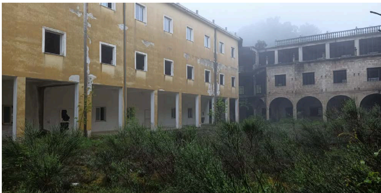
foto n° 23 - Vista esterna Immobile Bene 6 corte
