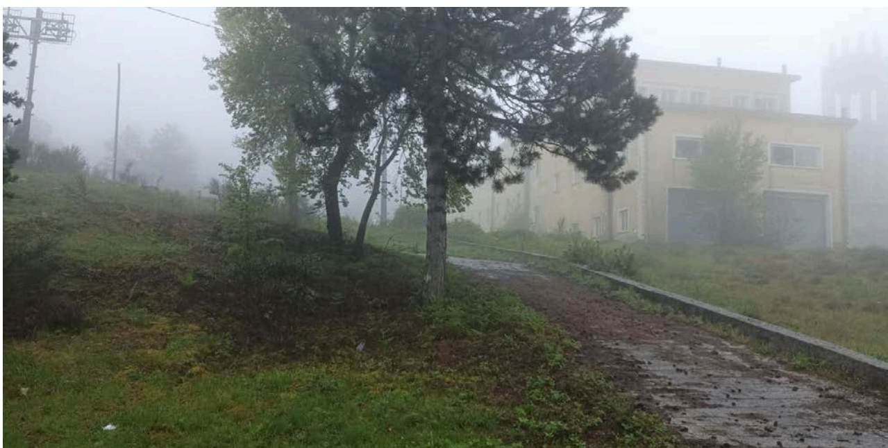
foto n° 21 - Vista esterna Immobile Bene 6 corte
