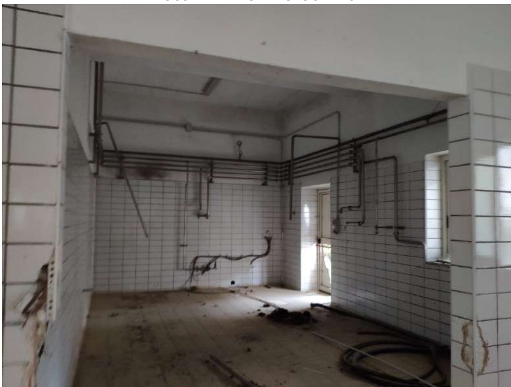
foto n° 7 - Vista interna Immobile Bene 1 Piano terra
