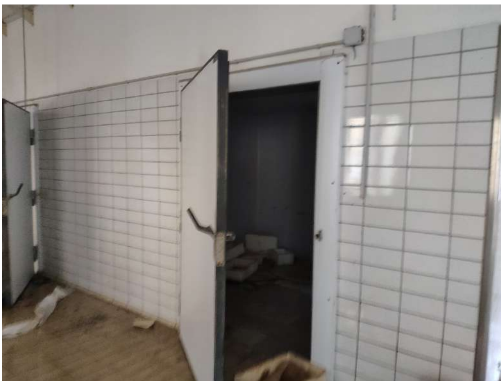
foto n° 8 - Vista interna Immobile Bene 1 Piano terra
