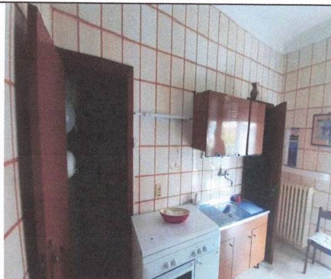
Vista interna cucina e rivestimento pareti
