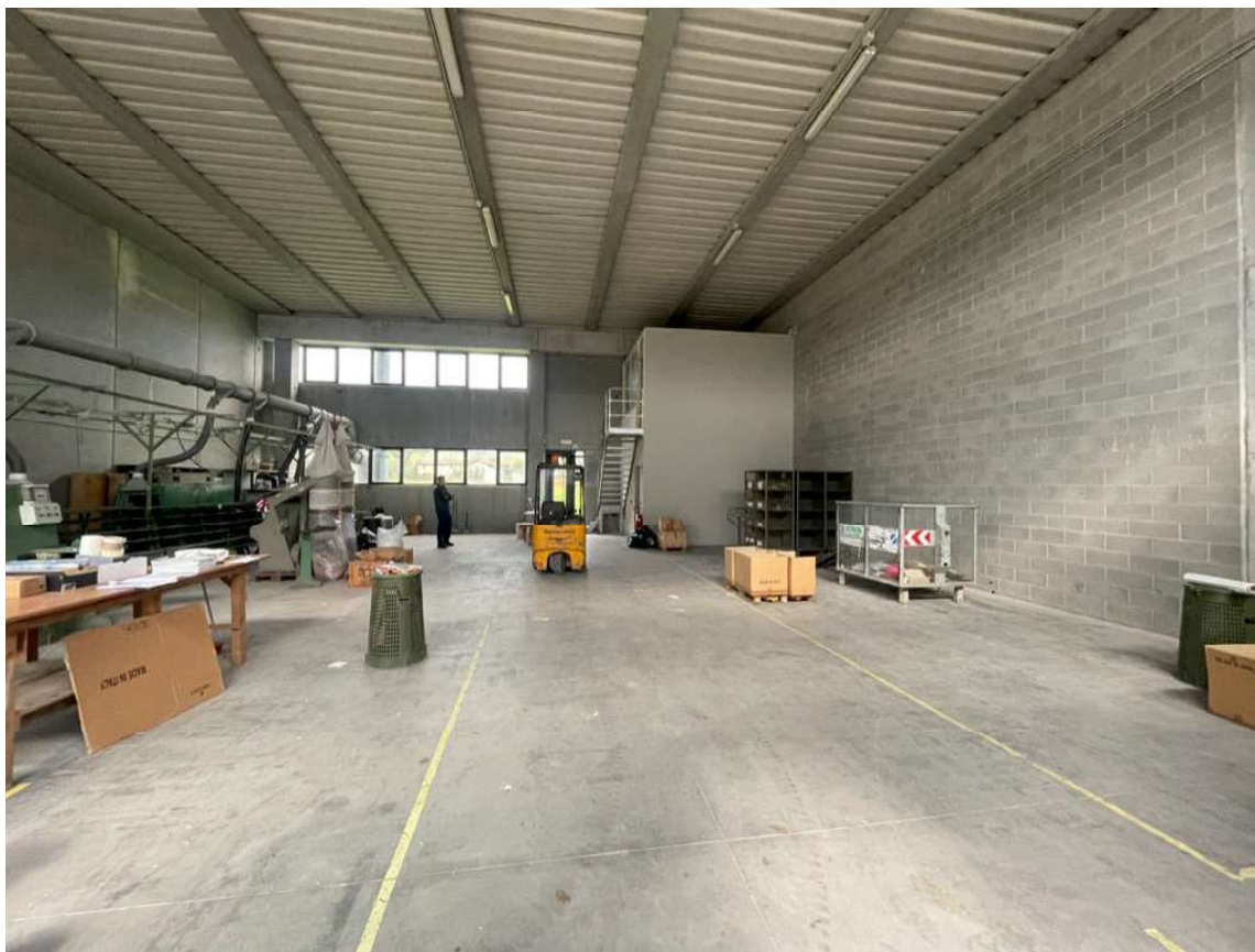
Foto 5 – Vista interna verso la facciata posteriore – Sulla destra blocco servizi e ufficio
