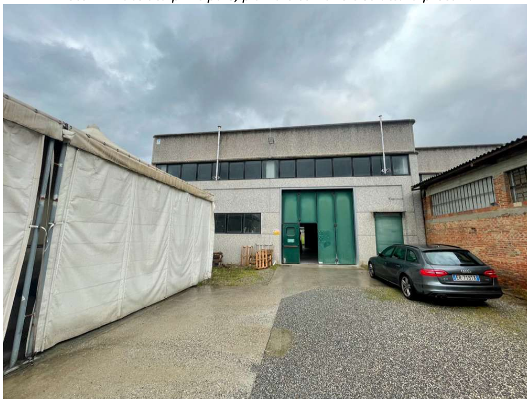
Foto 2 – Facciata principale, piazzale comune e struttura precaria
