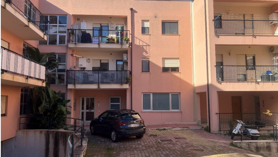
FOTO 1 - PORZIONE PROSPETTO VIA DON G. GIARDINA
