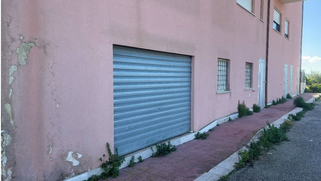
FOTO 7 - INGRESSO VIA R. SANDIAS
