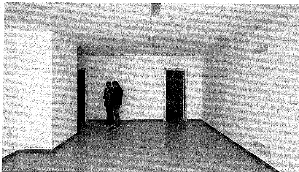
FOTO 2 - LOCALE INGRESSO SUB. 6
