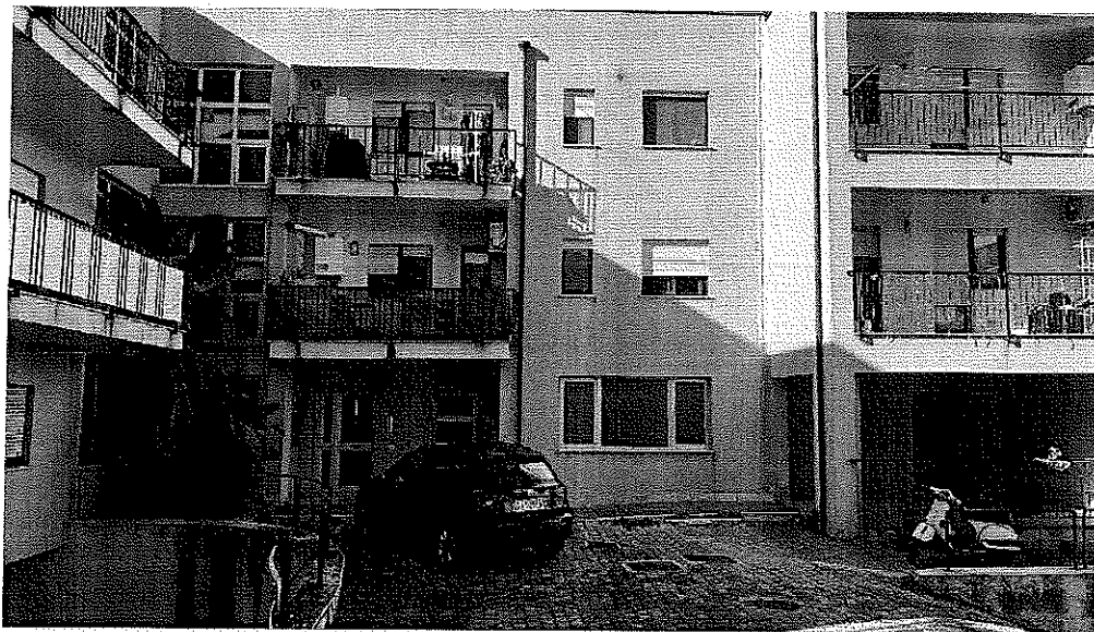
FOTO 1 - PORZIONE PROSPETTO VIA DON G. GIARDINA
