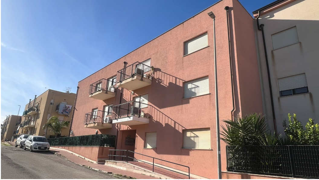
FOTO 1 - PORZIONE PROSPETTO VIA DON G. GIARDINA
