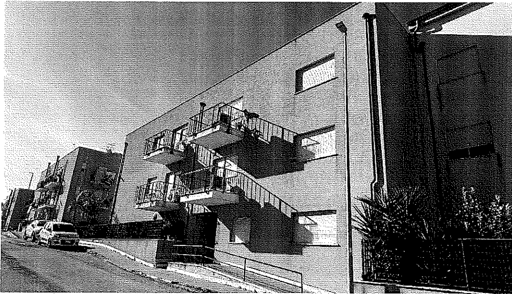
FOTO 1 - PORZIONE PROSPETTO VIA DON G. GIARDINA
