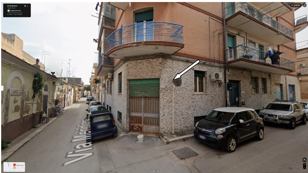
Figura 3: Locale Deposito in Foggia via Marasco/via Meridiana - (41.459605, 15.545571)
