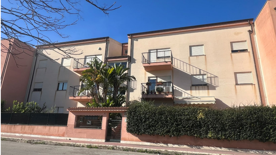
FOTO 1 - PROSPETTO VIA DON G. GIARDINA
