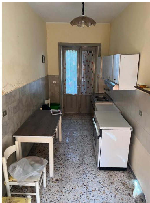
Foto 6. Cucina (sub 2) piano terra.
