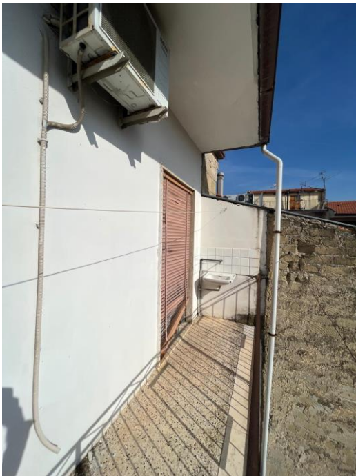
Foto 15. Ballatoio piano secondo.
