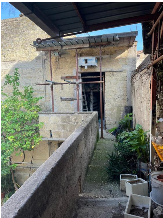
Foto 11. Piano primo ballatoio.
