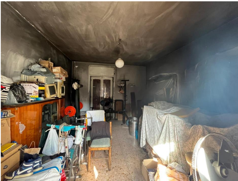
Foto 13. Camera 2 piano primo (sub 2).
