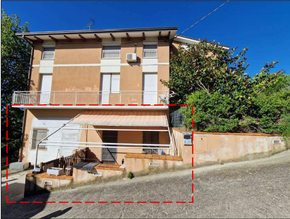
Foto 9: prospetto est e indicazione unità immobiliare oggetto di esecuzione immobiliare
