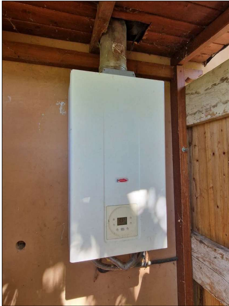
Foto 31: caldaia esterna
