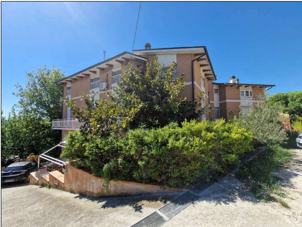
Foto 8: prospetto nord ed est
