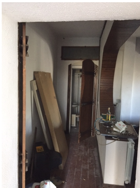
4 - Corridoio con vista della porta di accesso al bagno
