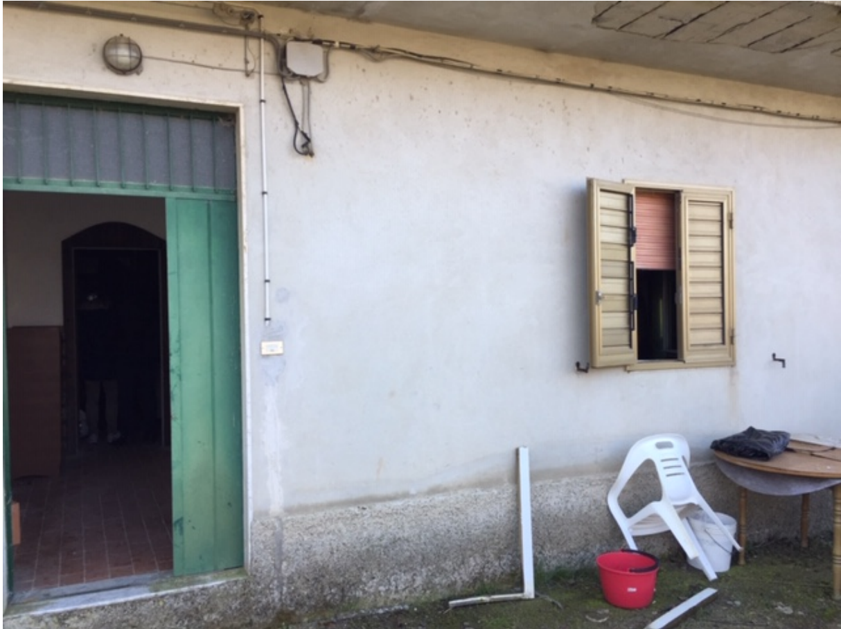
1 - Porta di accesso all'unità immobiliare dalla corte comune
