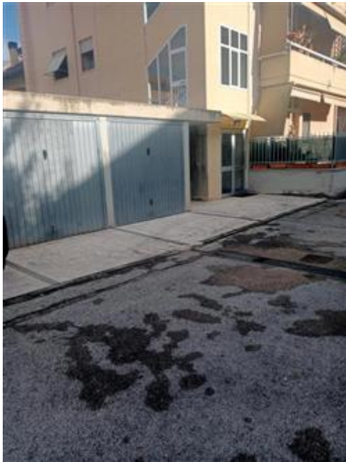
PARTICELLA 657 (ACCESSO VERSO GARAGE PART 96)
