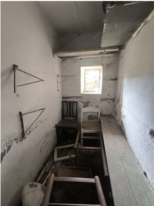
Foto 9: cantina, vano con finestra verso il cortile annesso
