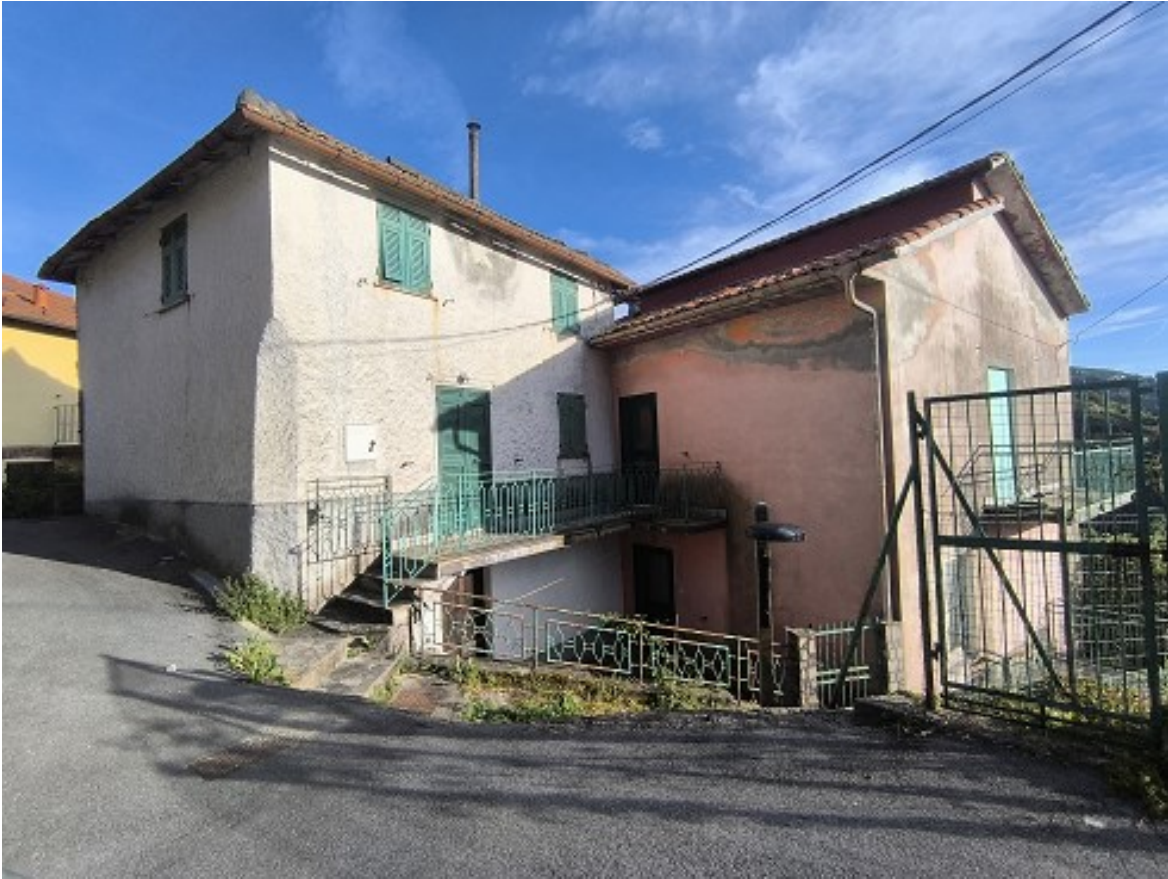
Foto 2: Fronte nord ovest
