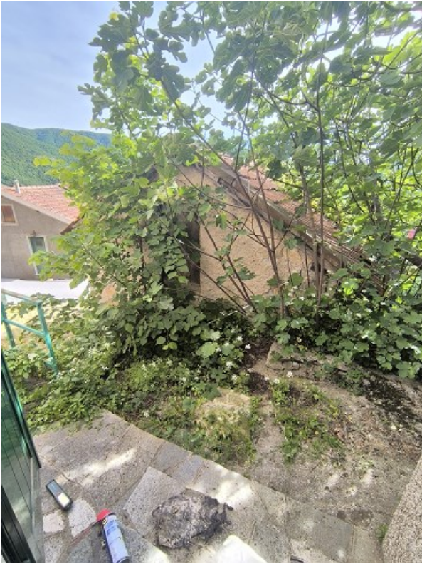
Foto 17: affaccio dell'ingresso dell'appartamento
