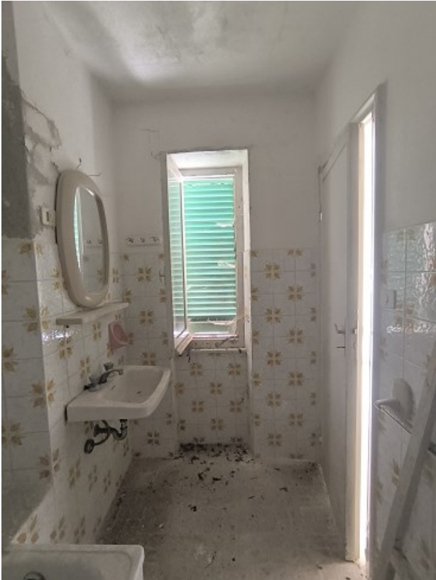
Foto 11-12: Bagno con finestra verso nord ovest
