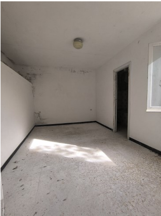
Foto 9: camera con finestra verso fronte di ingresso a sud ovest
