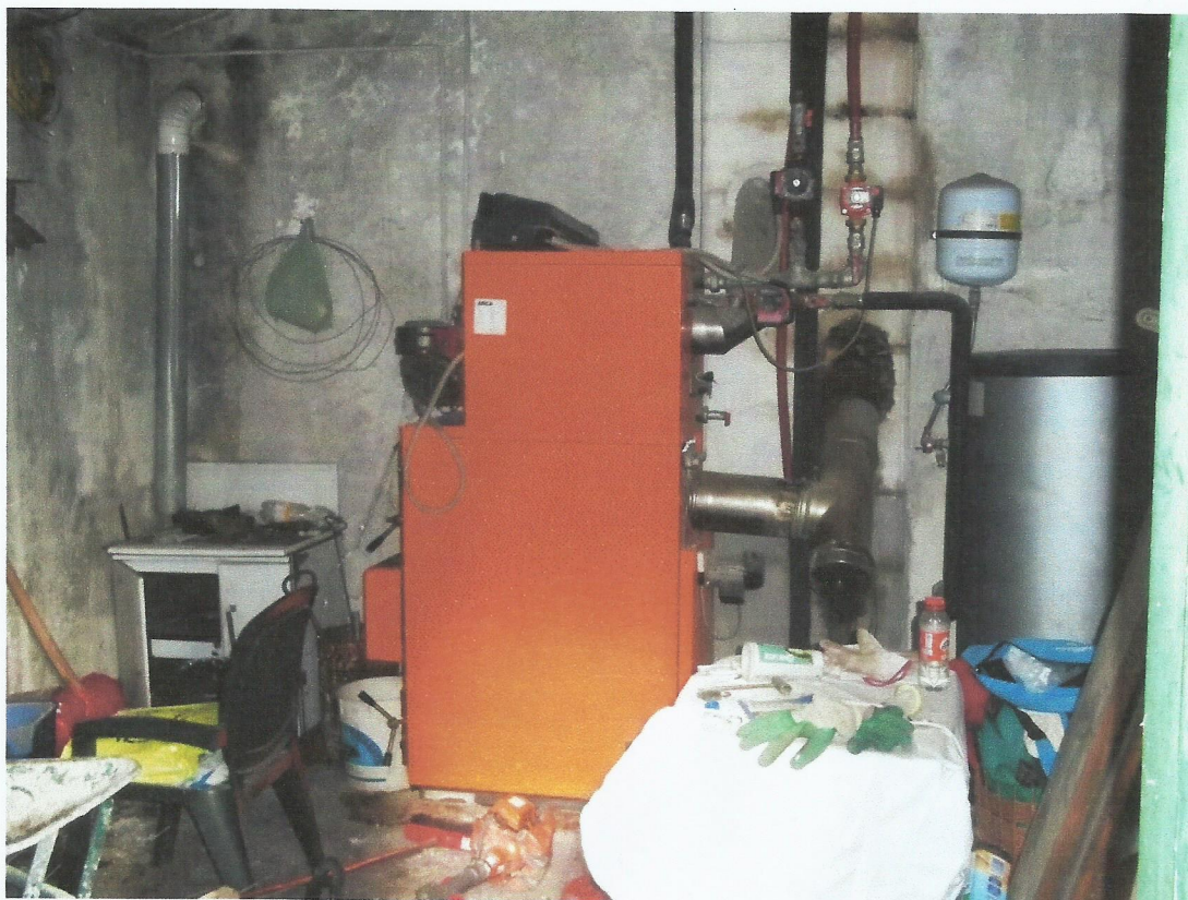
VISTA GARAGE A2 ADIBITO A DEPOSITO - LOCALE CALDAIA
