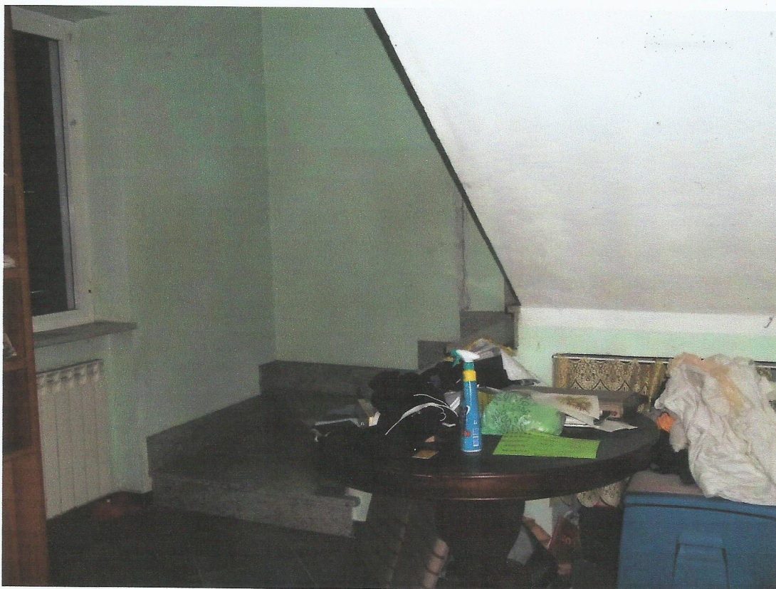
VISTA VANO SCALA PIANO TERRENO
