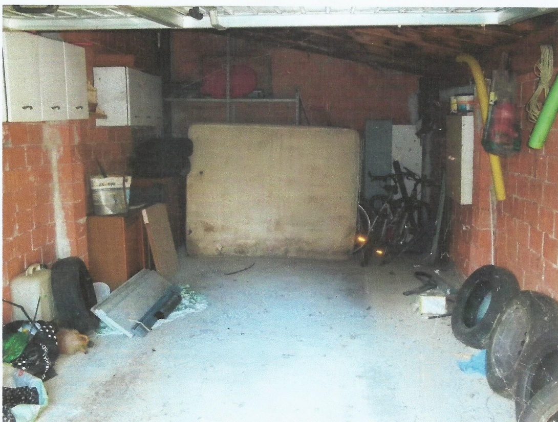
VISTA INTERNA GARAGE A1
