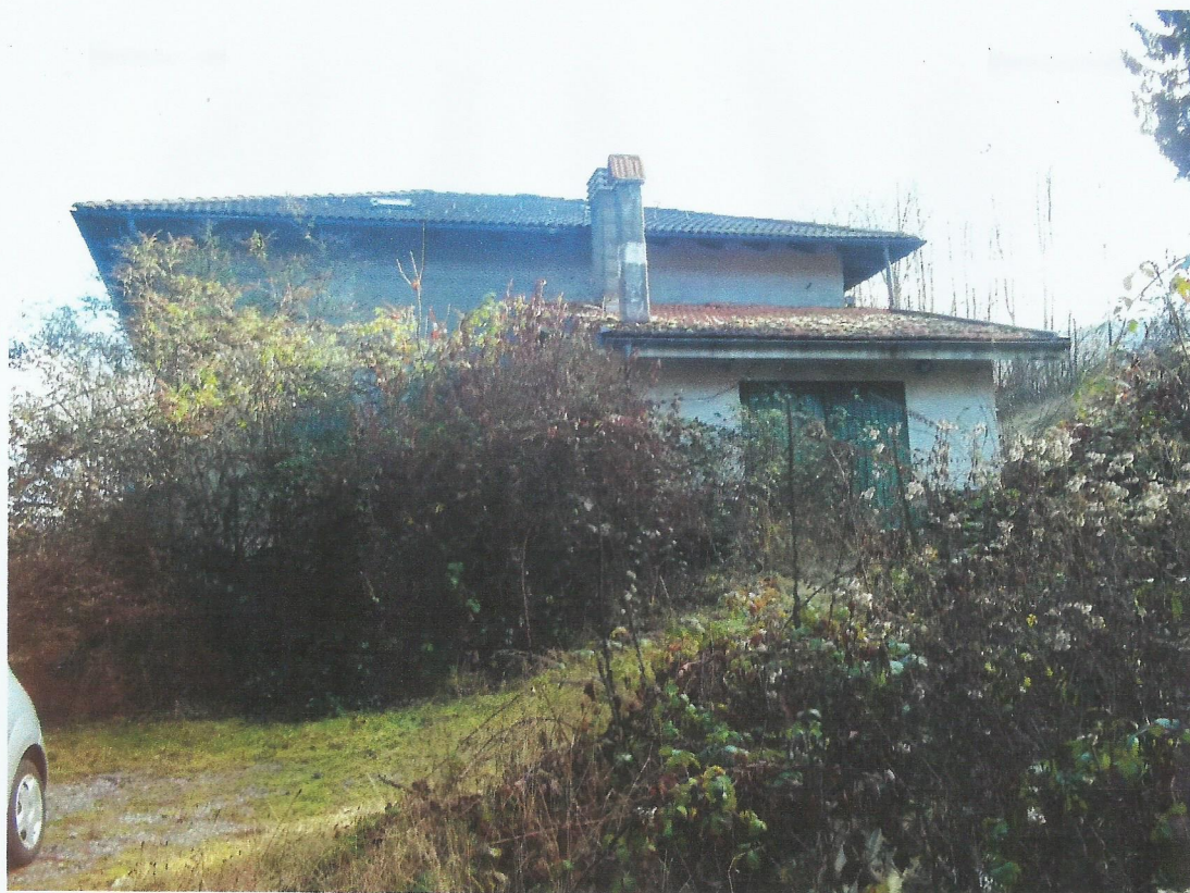
VISTA PROSPETTO LATERALE ABITAZIONE LATO OVEST
