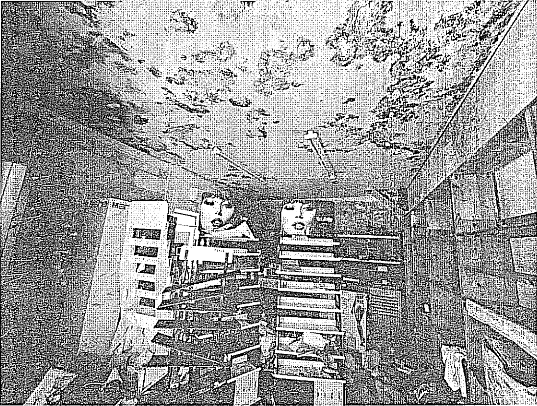
LOCALE INTERNO-PRIMA STANZA
