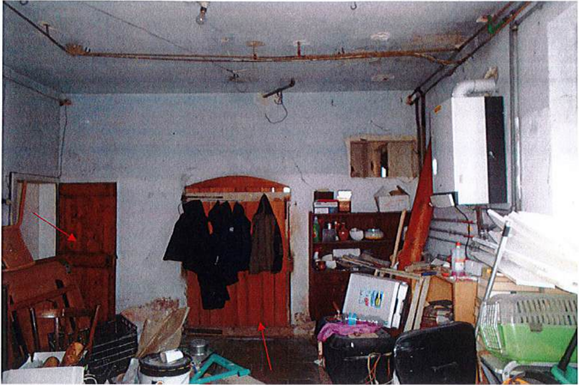
Interno magazzino con accesso interno e collegamento alla cantina
