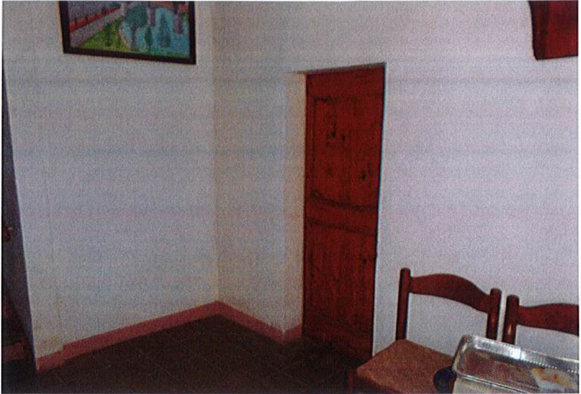
Porta accesso al locale magazzino
