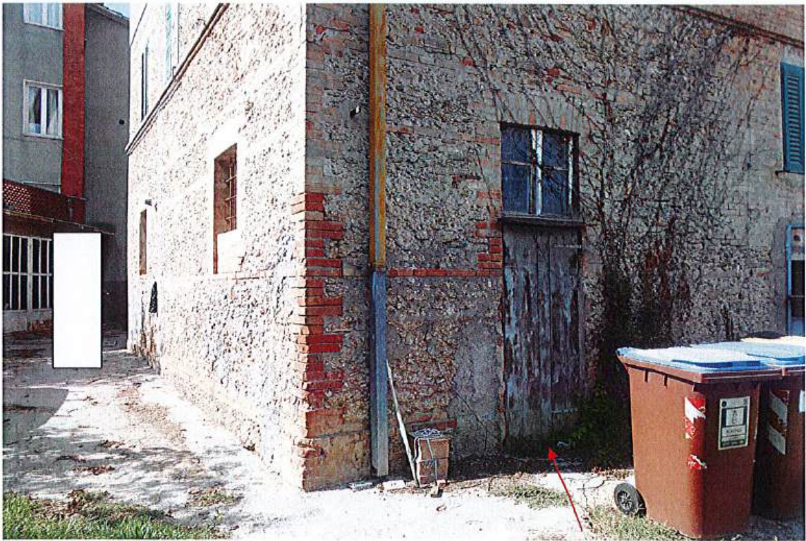
Accesso esterno al locale cantina
