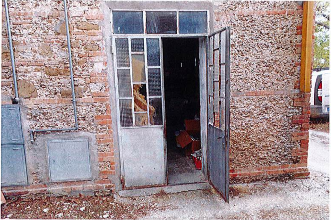
Accesso esterno al locale magazzino
