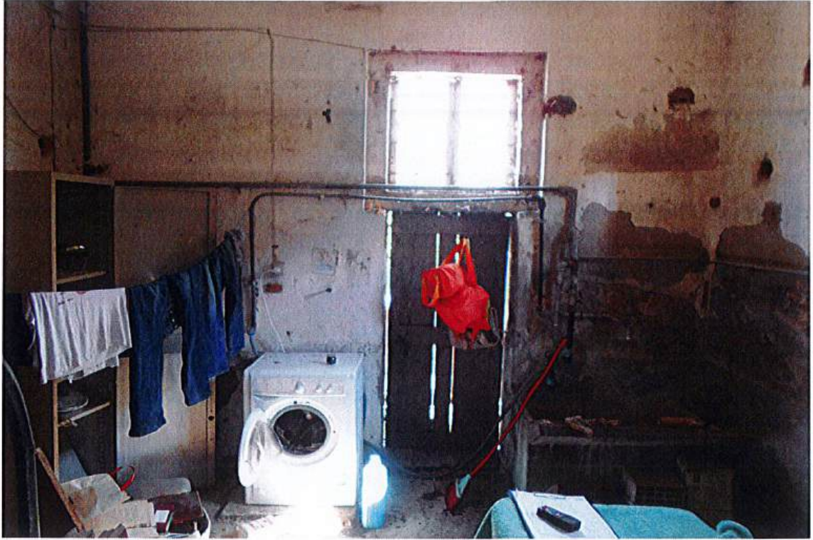
Interno locale cantina
