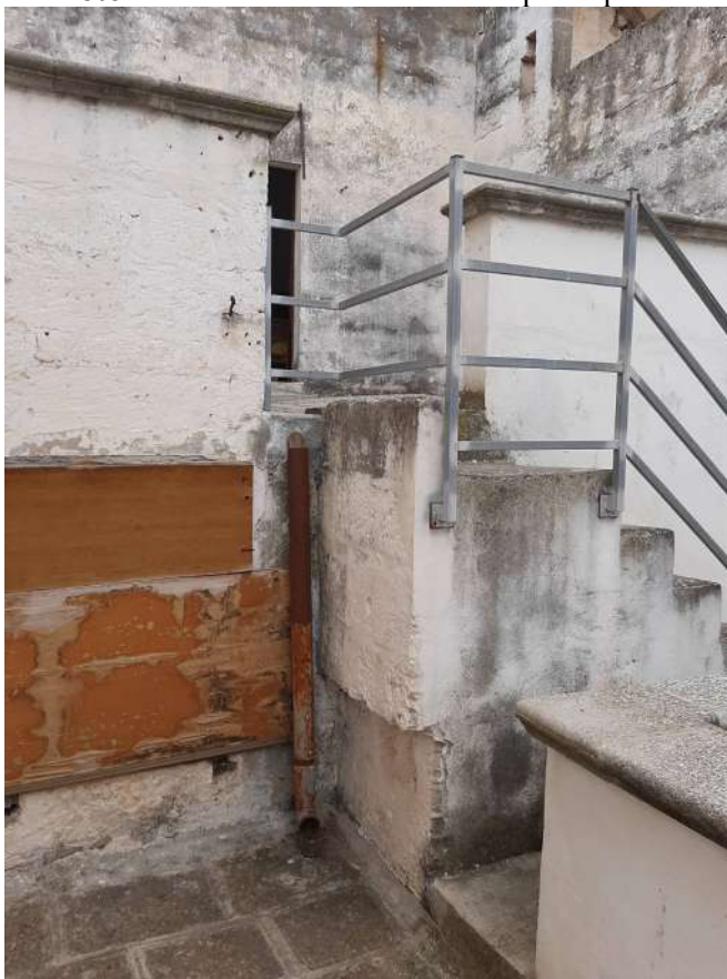
Foto 11 – Vista scala di accesso al piano primo
