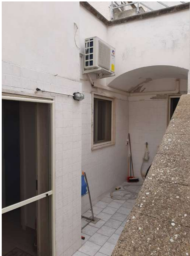
Foto 9 – Vista cortile interno retrostante al PT
