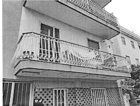
Vista immobile al piano primo
