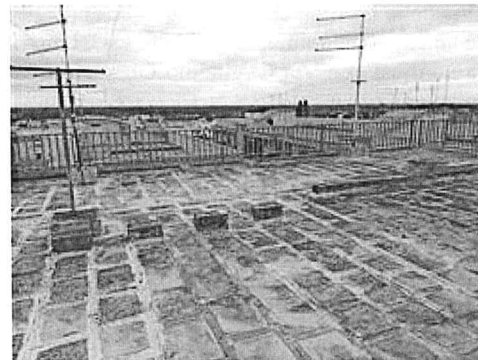
Vista lastrico solare al piano quarto
