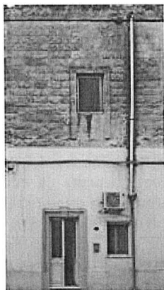
Vista prospetto immobile da Via San Pancrazio
